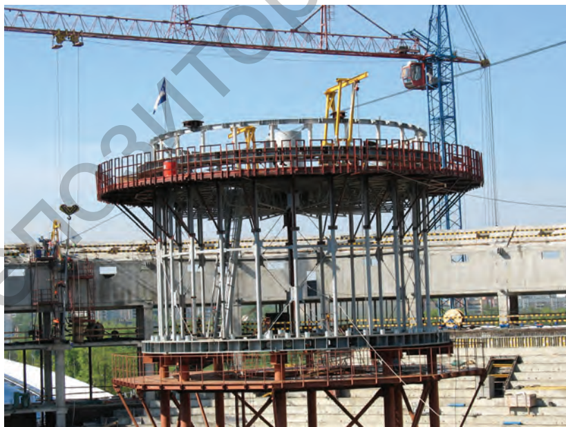
Уникальный купол покрытия «Минск-Арена» потребовал и уникальных конструкций на стадиях его возведения
