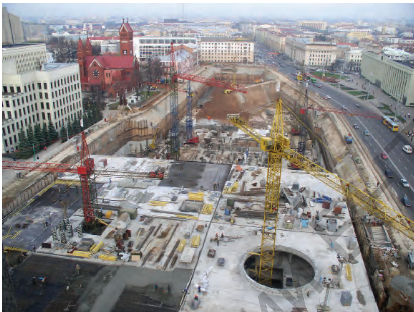
Панорама площади Независимости в процессе выполнения реконструкции, которую осуществляло ОАО «Минскпромстрой», предприятие с 1995 г. возглавляет выпускник 1975 г. В.С. Нехай
