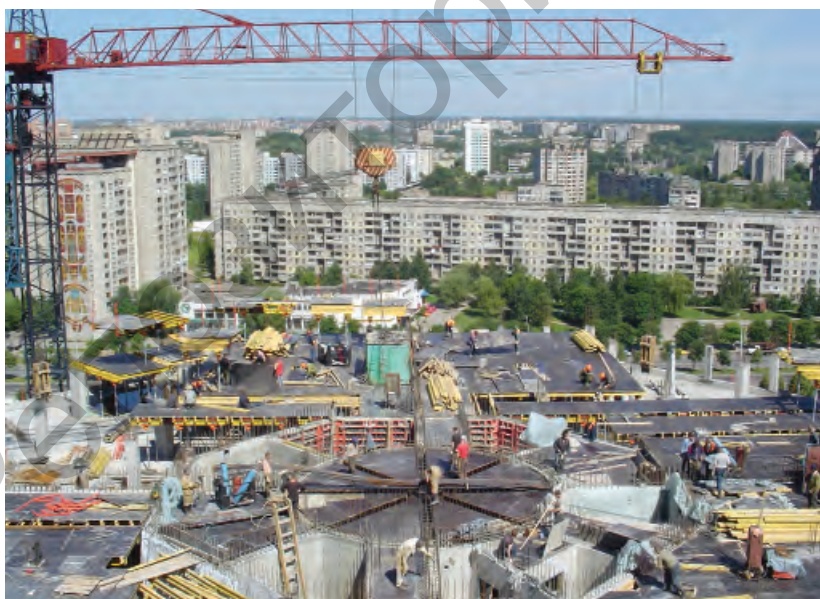
Так выглядела на начальной стадии строительная площадка возведения Национальной библиотеки Республики Беларусь. Генеральный подрядчик ОАО «Стройтрест №7», ГПО «Минкстрой»
