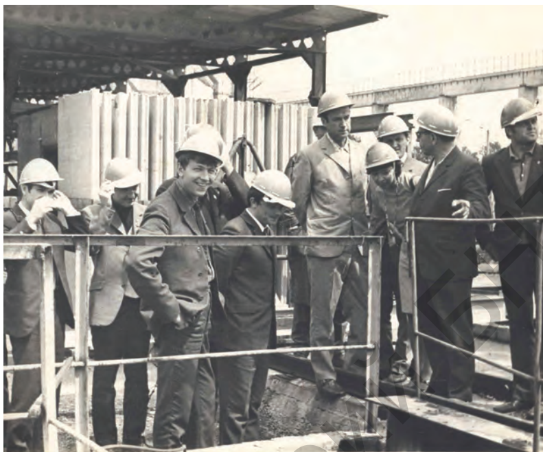
Посещение студентами 4 курса ПГС Вроцлавского ДСК, построенного в ПНР строителями г. Москвы. 1974 г.
