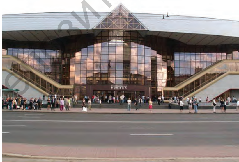
Здание железнодорожного вокзала в г. Минске, работы выполнялись Стройтрестом №7
