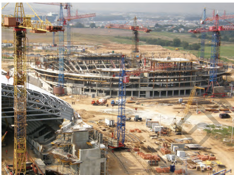
Панорама строительства комплекса «Минск-Арена» на начальной стадии работ. Генеральный подрядчик ОАО «Минскпромстрой», ГПО «Минскстрой»
