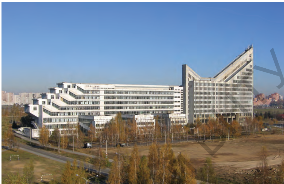
Учебный корпус БПИ №15 по завершению строительства. 1982 г.
