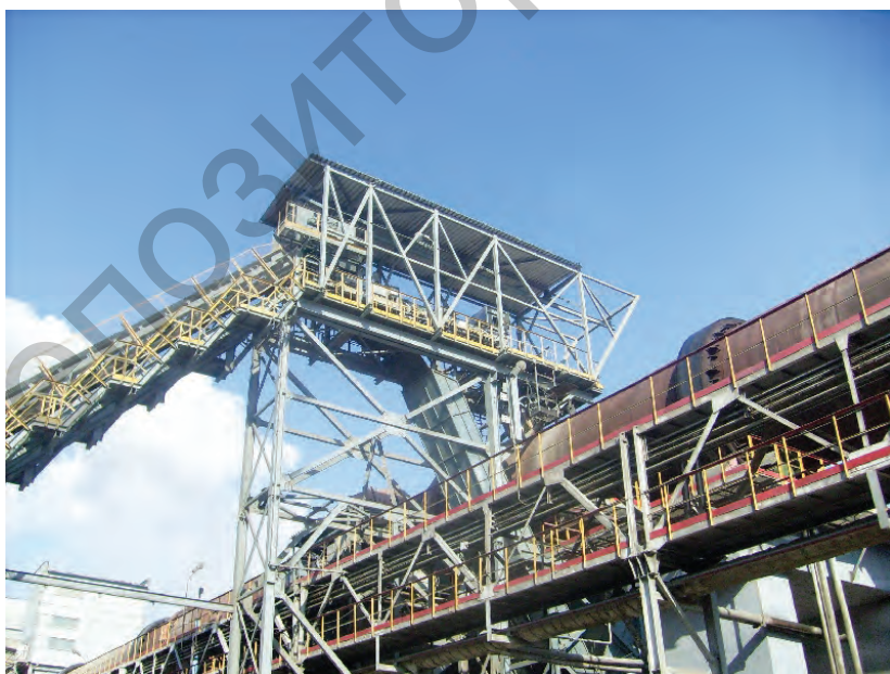
Фрагмент промышленного объекта, построенного по проекту ОАО «Институт «Гродногипрострой»
