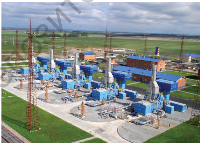
Компрессорную станцию на трассе газопровода «Ямал-Европа» ОАО «Минскпромстрой» возвело со значительным сокращением сроков
