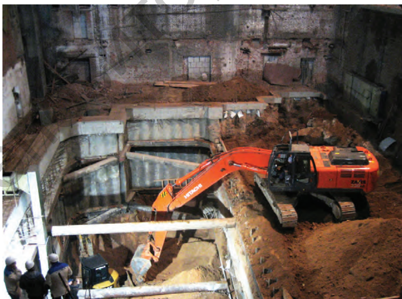
На месте сцены котлован, в котором строители ЗАО «Эльвира» возведут новые технические этажи театра
