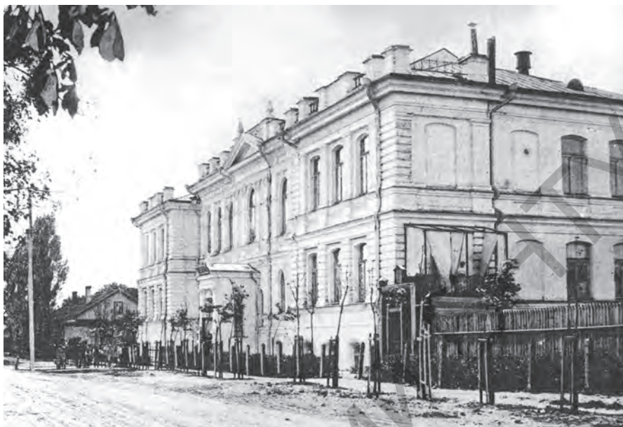
Здание бывшего коммерческого училища в Минске по Васильевскому переулку, 4. Здесь в 1920-1922 гг. размещался БГПИ, на втором этаже справа помещения строительного факультета.
