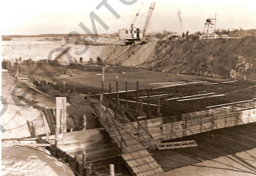
Строительство 15 корпуса набирает темпы
