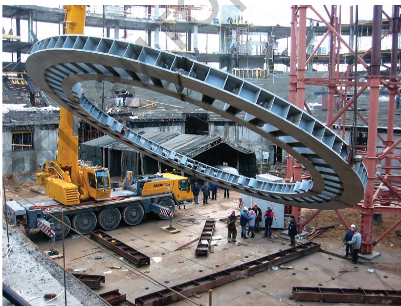
Уникальная инженерно-техническая операция монтажа опорной конструкции фиксирующей огромный купол покрытия «Минск-Арена»
