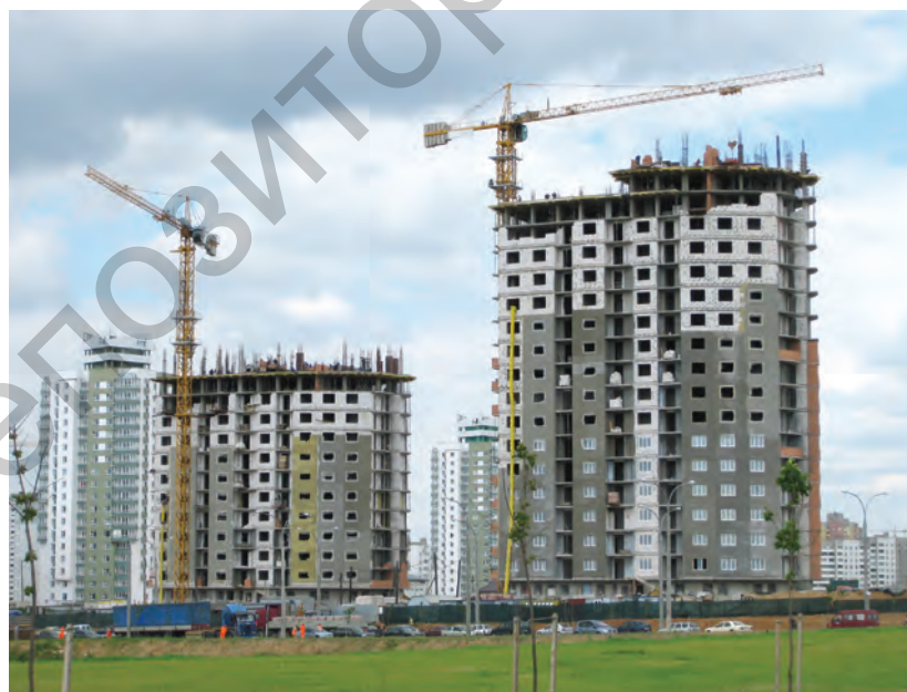
Строительство 25-этажных энергоэффективных домов. Объекты ОАО «10 УНР». Предприятие многие годы возглавляет В.А. Устинчик, выпускник 1977 г.
