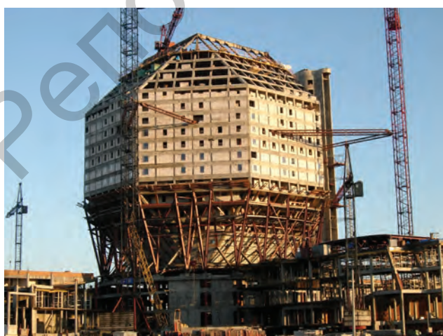
Уникальные опалубочные системы использовались при возведении высотной части здания Национальной библиотеки
