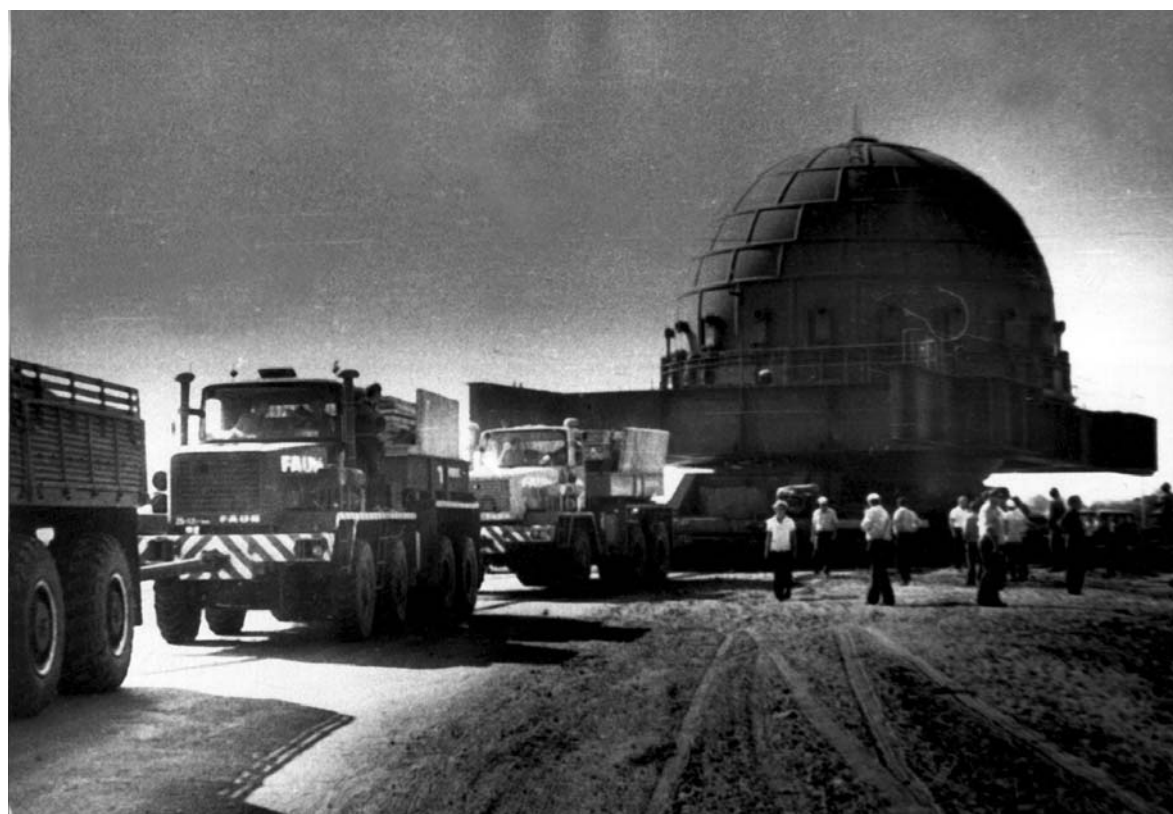
Транспортировка взрывной камеры
