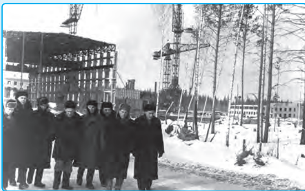
Изучаем строительные конструкции Белоярской АЭС, февраль 1960 года.
