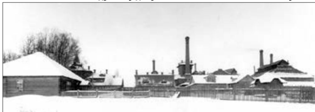
Вид на завод в Дружной Горке со стороны реки
