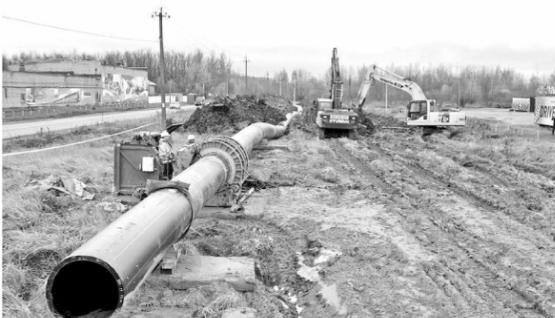
В Великом Новгороде начали прокладку одного из самых больших водоводов. Труба диаметром 900 миллиметров и длиной километр пройдёт от Левобережных очистных сооружений Новгородского водоканала до перекрёстка с Орловской улицей и заменит собой старую, износившуюся. Когда новую трубу подключат, это обеспечит бесперебойную подачу питьевой воды 120 тысячам жителей Великого Новгорода. Она же будет питать предприятия Северного и Западного районов города и деревни Сырково, а также ПАО «Акрон».
