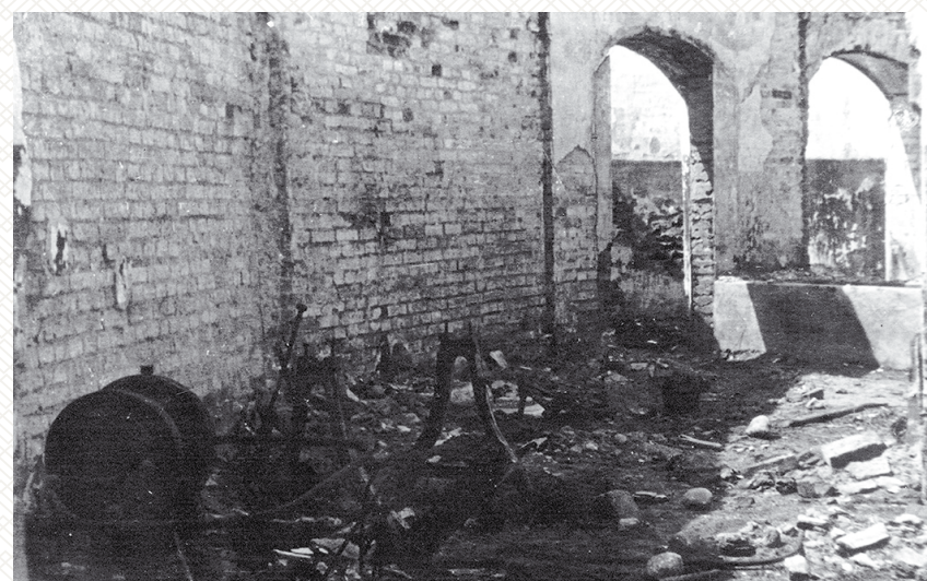
Разрушенные здания: сверху – рольного отдела, внизу – древесно-массного цеха. Июль 1944 года
