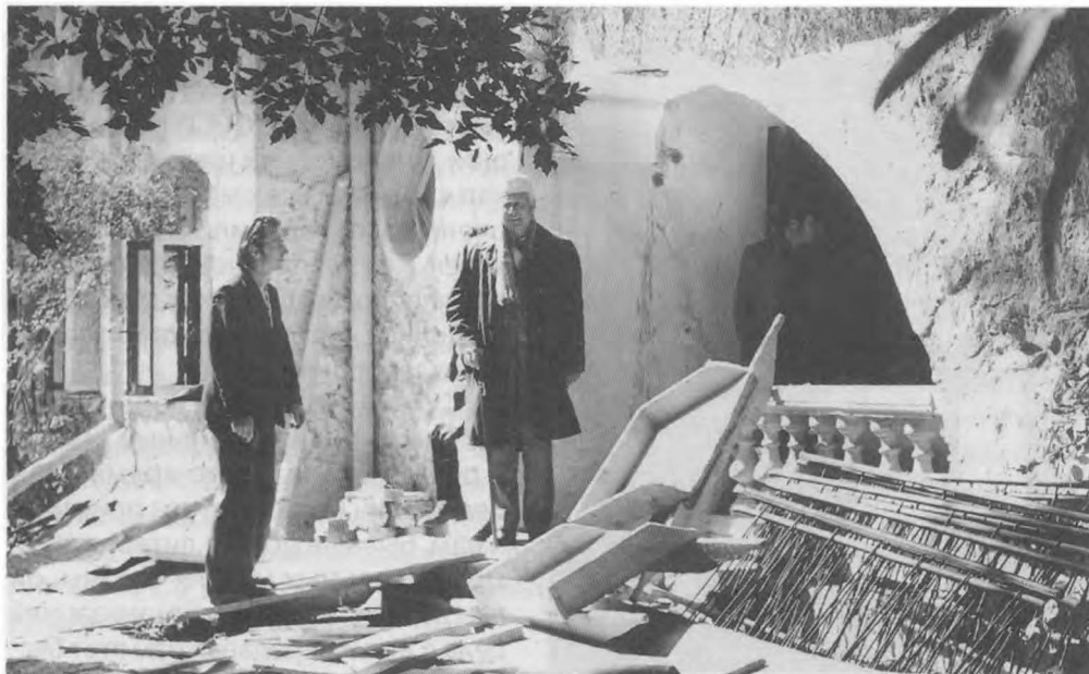
Одно из посещений И.С.Козловским музея в период ремонтных работ
