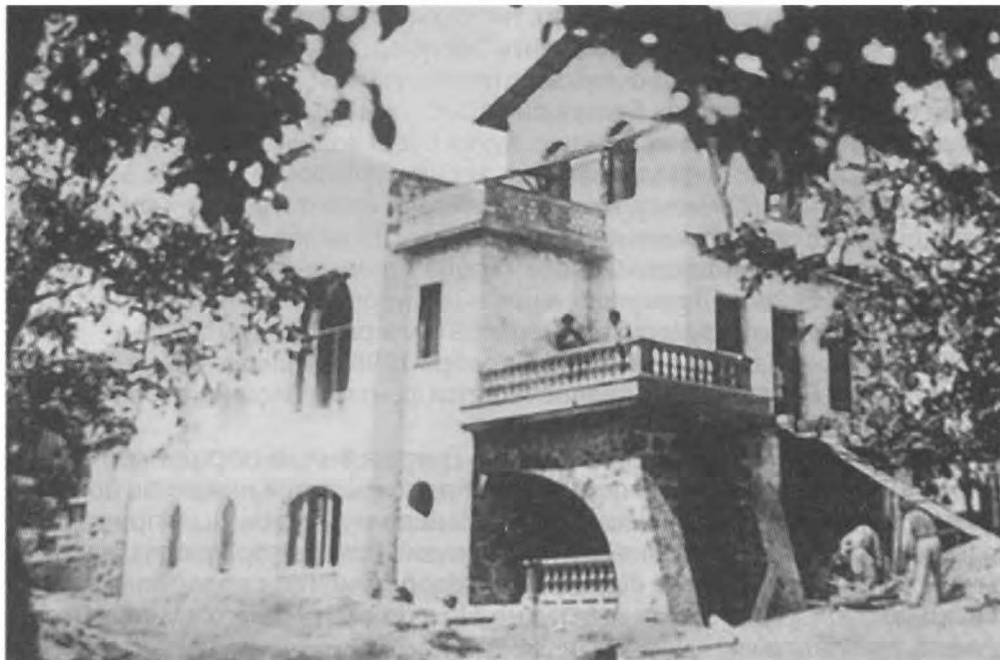
Строительство дома А.П.Чехова в Ялте
