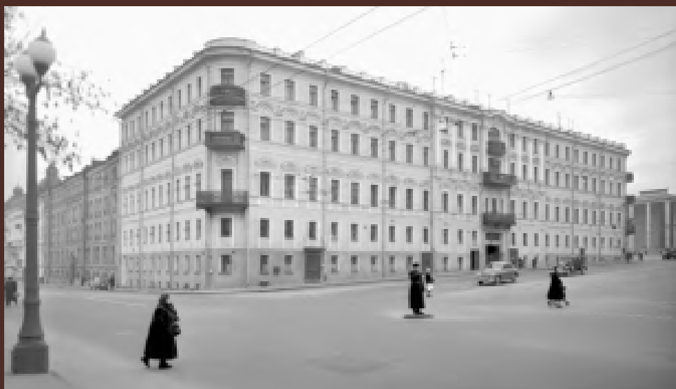
Здание Исполкома Коминтерна в Москве, на Воздвиженке. 15 октября 1954. Фото Н. Грановского (ЦГА Москвы)
