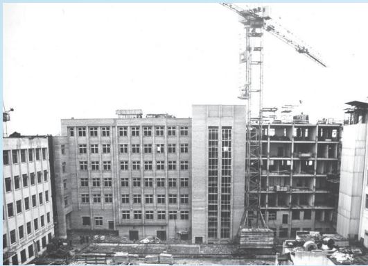
Растем... Этаж за этажом, корпус за корпусом
