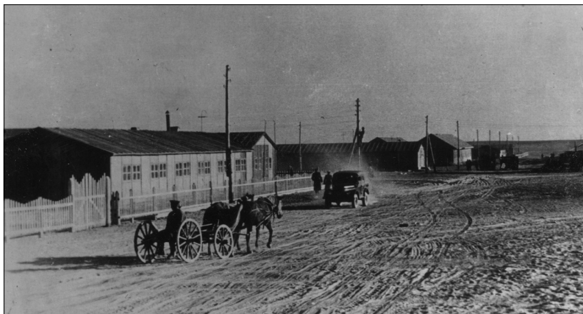
Будущий Байконур — площадка № 10. Октябрь 1956 года
