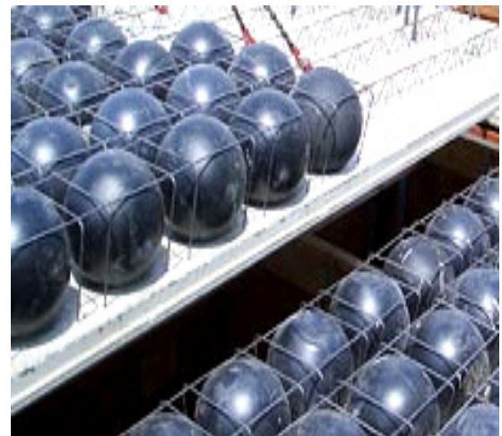
Рис. 8. Плоские двухслойные сборно-монолитные плиты с пустотами в виде шаров ( КР4-2 ).
