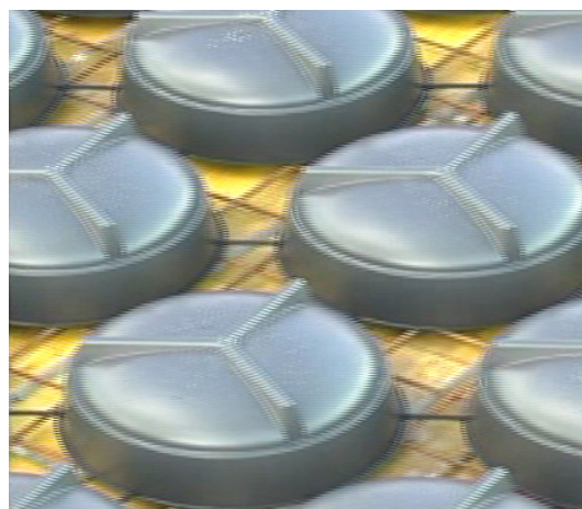
Рис. 5. Плоские плиты с пустотами в виде перевернутых колпаков.
