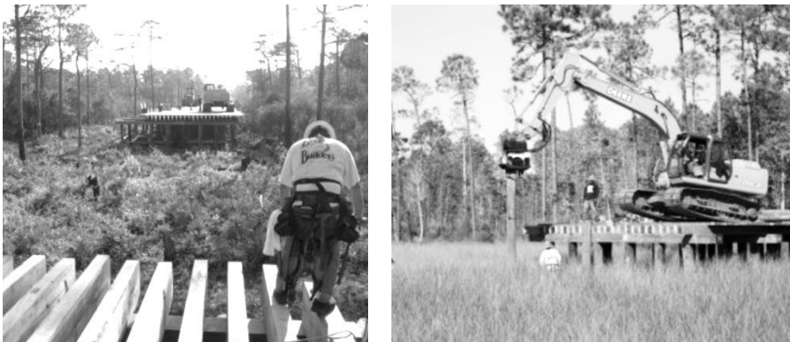
Рис. 14. Метод будівництва «згори-вниз»
