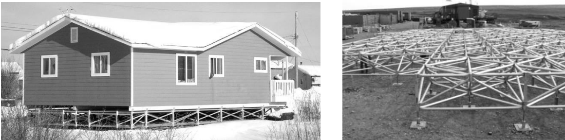
Рис. 11. Просторові фундаментні плити
