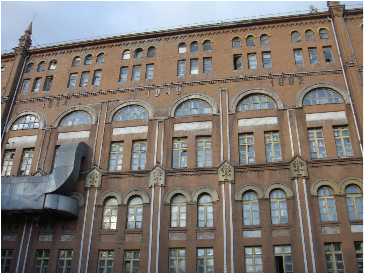
Фото здания мельницы, 2016 г.
