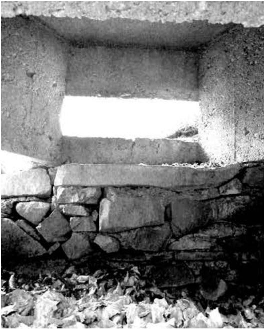
Фото 4. Бутова кладка під залізобетонним ковпаком у Підполозянському вузлі оборони (фотографія Максима Юценка, м. Київ).
