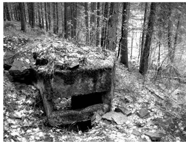
Фото 13. Залізобетонний ковпак у Синевирському вузлі оборони
