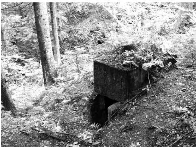
Фото 11. Залізобетонний ковпак у Синевирському вузлі оборони.
