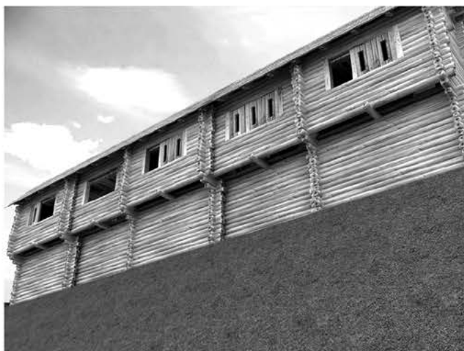
Рис. 6. Реконструкції двох'ярусного оборонного укріплення. Перший ярус – чотиристинна городня. Другий ярус (заборол): А – стоякова-балковий каркас; Б – зрубна конструкція. Верхня частина заборол складається з прямокутних дерев'яних щитів, що відкриваються всередину. У щитах виконані вертикальні прорізи-бійниці. Реконструкція В. Лук'янченка і В. Янченка. Малюнок О. Левченка.
