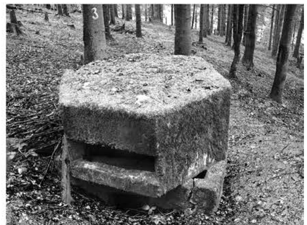
Фото 3. Залізобетонний ковпак у Синевирському вузлі оборони.
