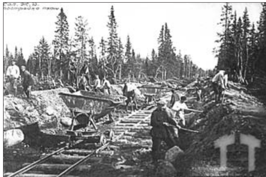
Прокладання залізниці на Соловках. Кінець 1920 рр.
