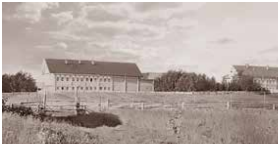
Дома М.С. и И.С. Гусевых в д. Овсянниковская. Фото нач. XX в. Дом брата Ивана Семёновича – старший из гусевских домов-исполинов. – Двухэтажный шестистенок с 14 окнами по главному фасаду
