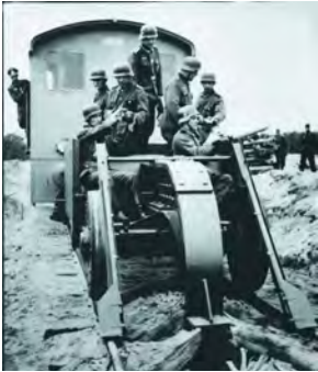
Ил. 3–4. Немецкий крюк разрушает железнодорожный путь. Немцы-«механизаторы» руководят работами.
