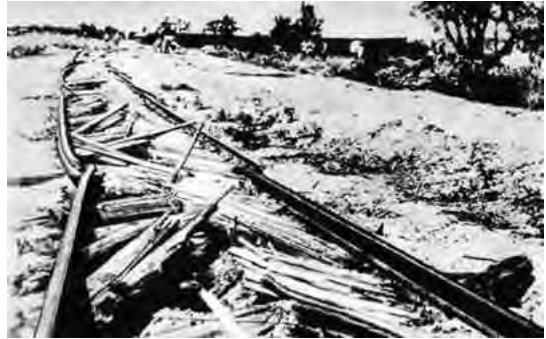
Ил. 3–4. Немецкий крюк разрушает железнодорожный путь. Немцы-«механизаторы» руководят работами.
