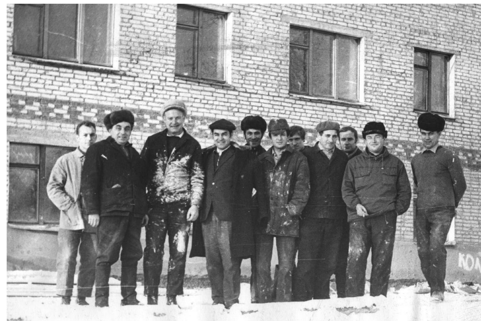
Ректор Д.П. Лобанов на субботнике, ввод в эксплуатацию общежития на Загорском полигоне
