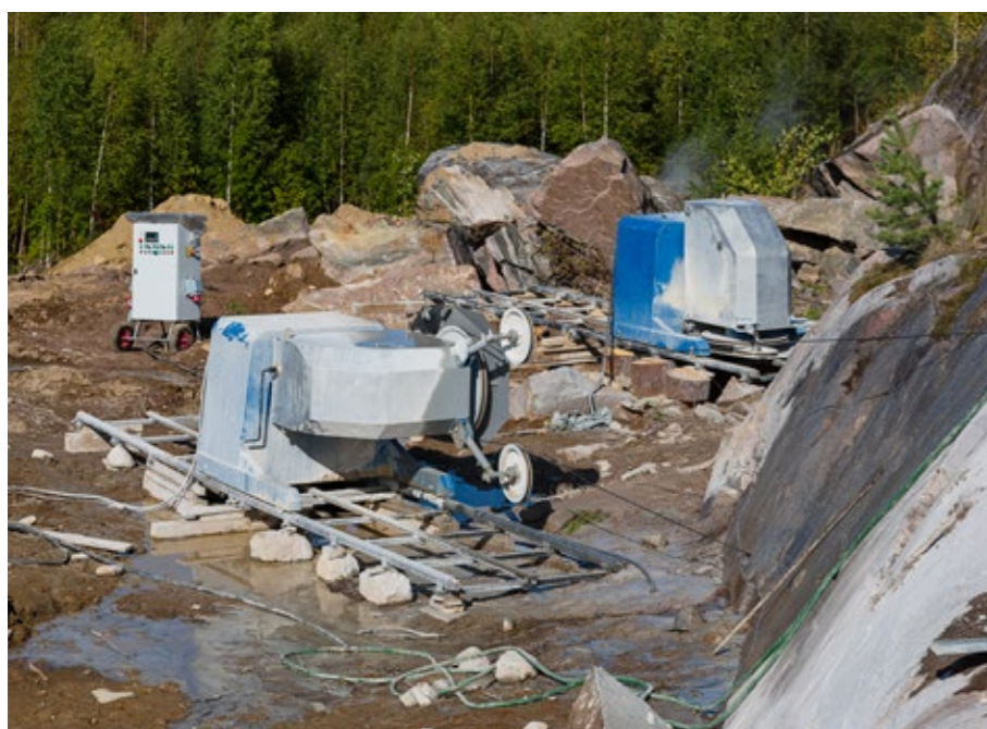
Подготовка блоков с применением алмазных канатов.
