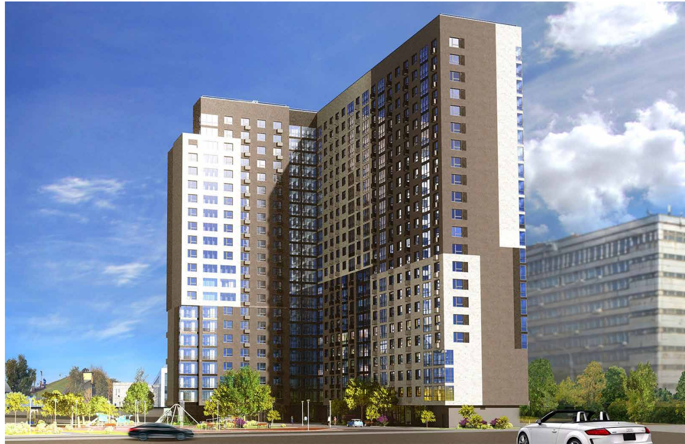
Новостройка по адресу Электротриумфальный проезд, вл. 7а
