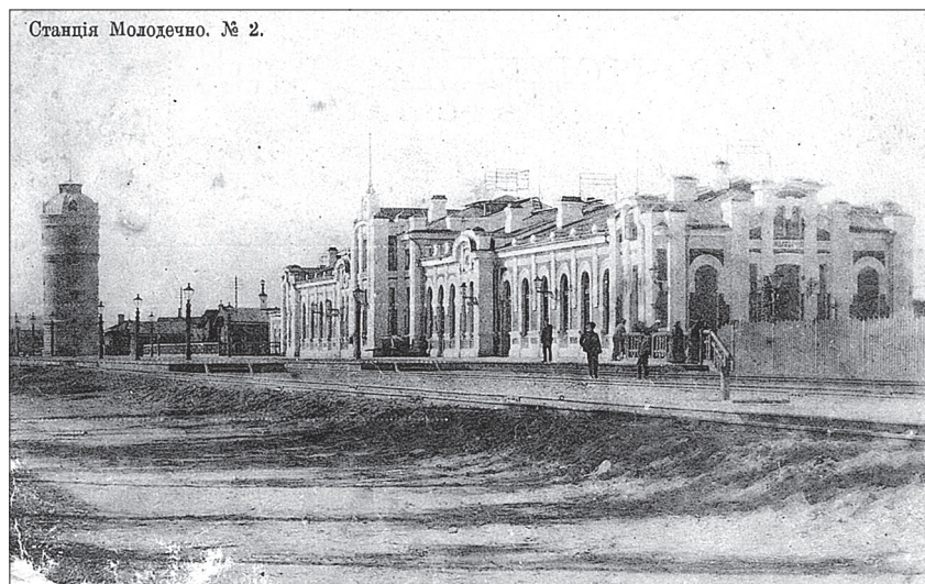
Станция Молодечно. Вид на вокзал и водонапорную башню
