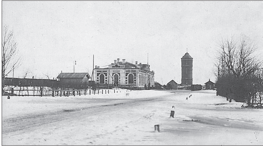
Дорога на железнодорожную станцию Вилейка. Вид на вокзал и водонапорную башню. Фото Б. Бермана
