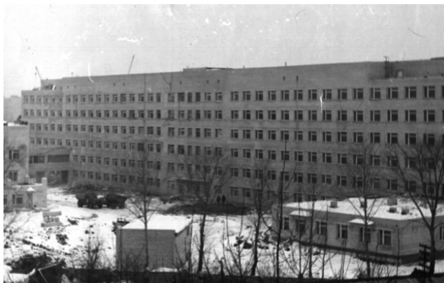
Строительство хирургического корпуса
