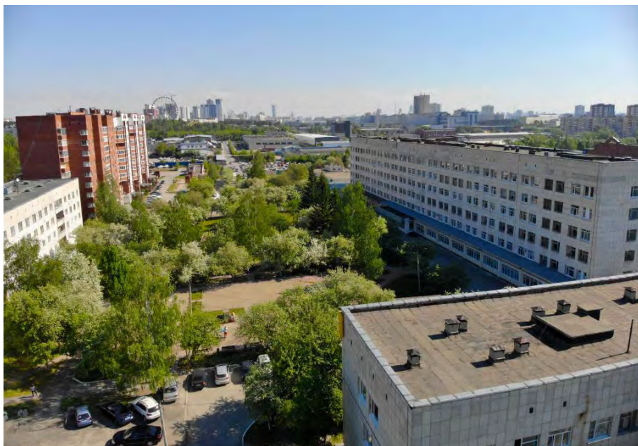
ОДКБ – вид с высоты
