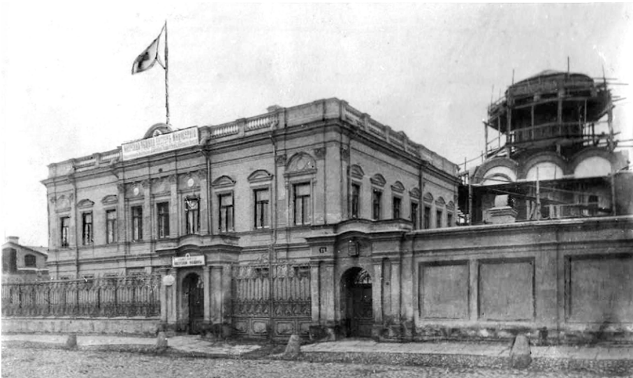
1899 г. Здание больницы и строящийся Храм Иверской иконы Божьей Матери
