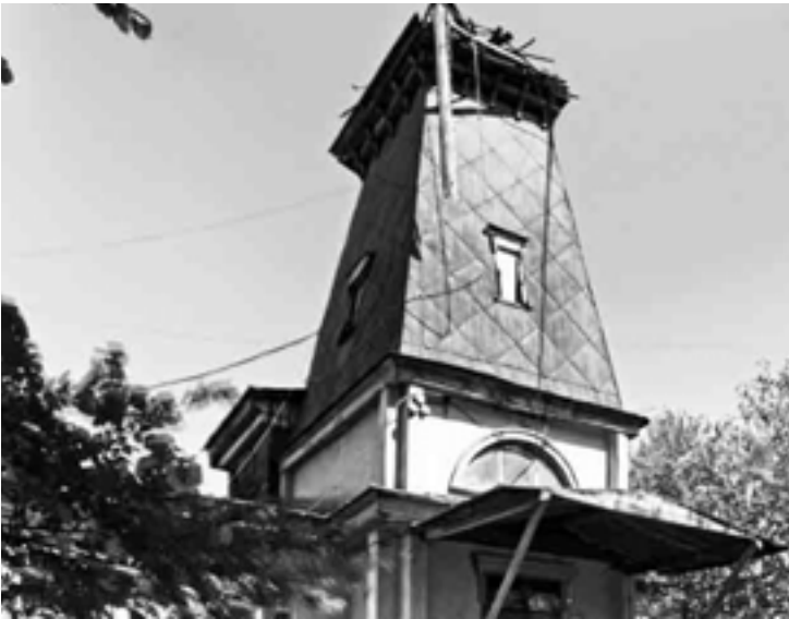
Das Gebäude der Wetterstation in Werny nach der Rekonstruktion.
