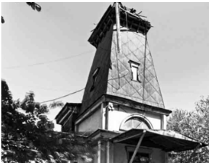
Верненская метеостанция после реконструкции.
