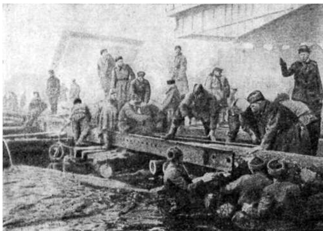
Подразделения инженерных войск строят мостовую переправу. 1945 год
