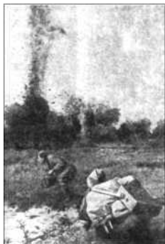
Телефонисты прокладывают линию связи
