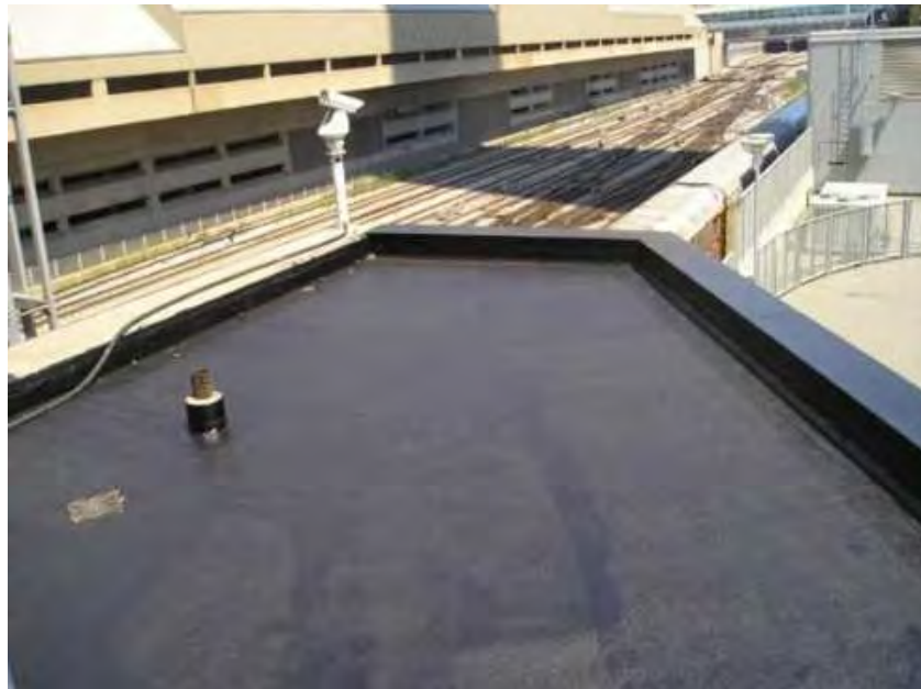
Рис. 3. Крыша здания, покрытая жидкой резиной Vodipren spray 100
