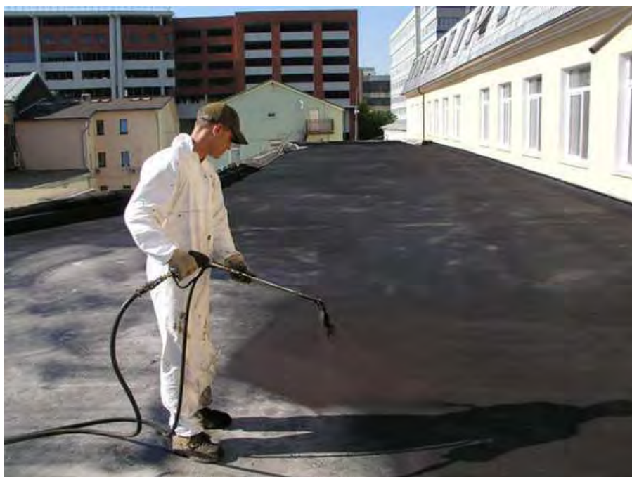
Рис. 1. Нанесение жидкой резины Vodipren spray 100
