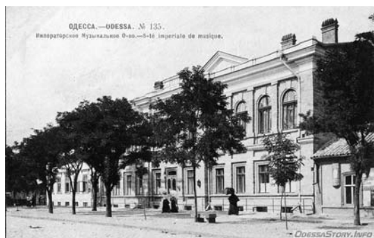
Ил. 6. Здание Одесского музыкального училища – позже Одесской консерватории, ныне – Одесской национальной музыкальной академии имени А.В. Неждановой
