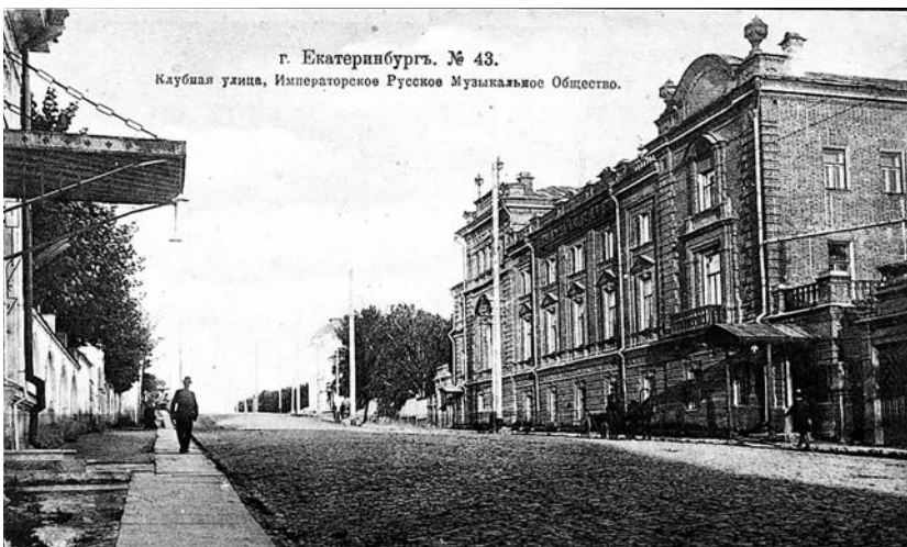
Ил. 1. Дом отделения ИРМО / РМО в Екатеринбурге (1912–1919 гг.). Здание выстроено по заказу И. З. Маклецкого в 1900 году (архитектор Ю. Дютель). В настоящее время Концертный зал Свердловского музыкального училища им. П. И. Чайковского
