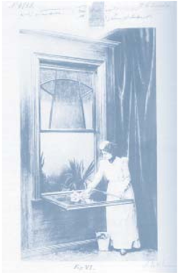
Sistema aperfeiçoado de janelas corrediças e contrapeso, denominada guilhotina. Inventor: Rodolfo Ahrons, 1906. Privilégio Industrial 4442. Patente concedida. Tinha por objetivo facilitar a limpeza e a ventilação. (Arquivo Nacional)
