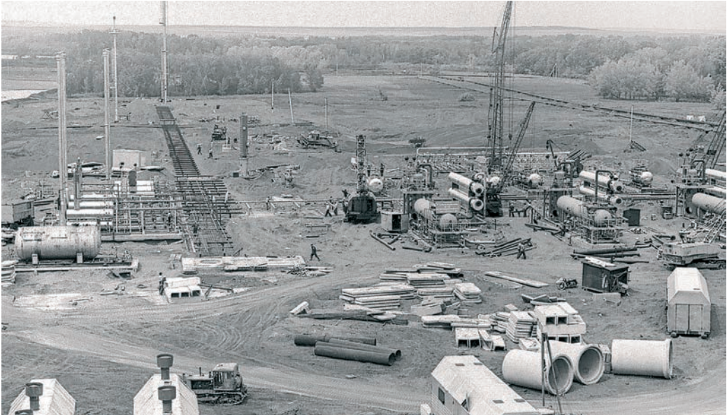
| На строительстве УКПГ-14
