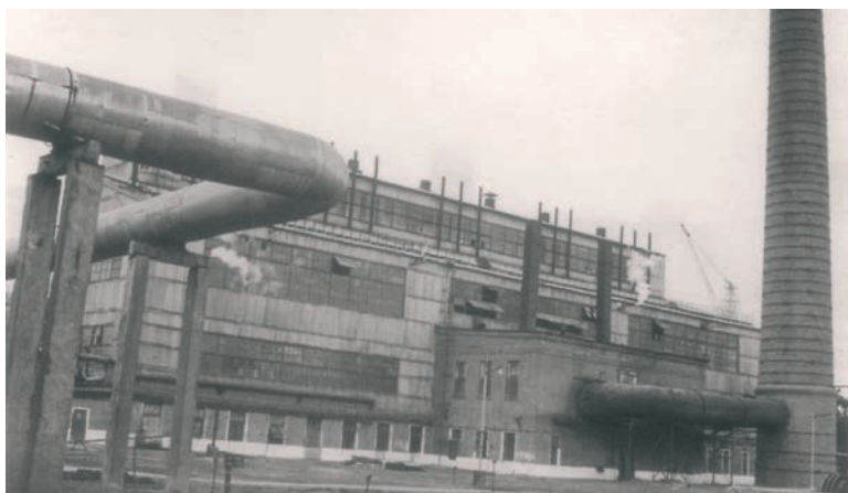
Установка печей расщепления в цехе конверсии углеводородов
