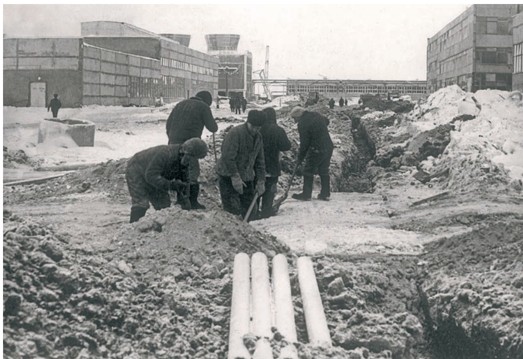
| Рытье траншеи для прокладки подпитывающего кабеля
