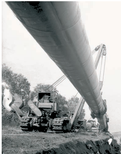
| Укладка трубопровода
