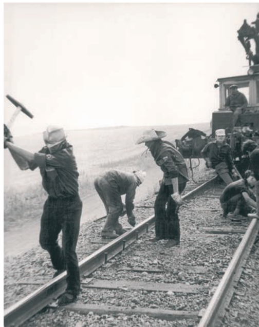
| Строительство железной дороги. 1970-е годы
