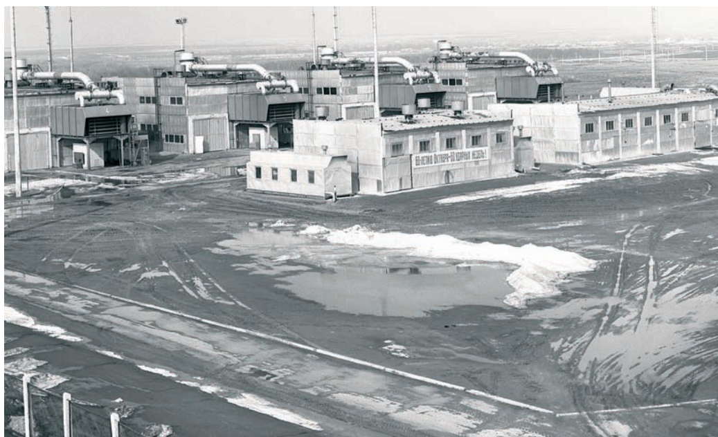
| Строительство Алексеевской компрессорной станции газопровода Оренбург – Новосков. 1977 год
