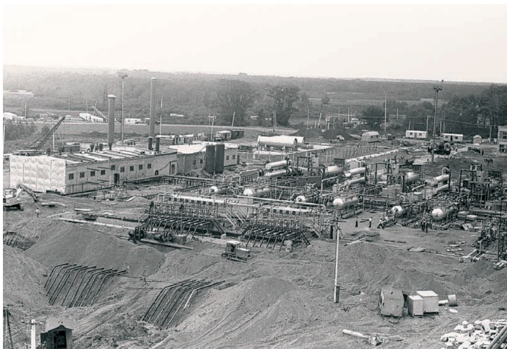
| Строительство ГП-12. 1978 год
