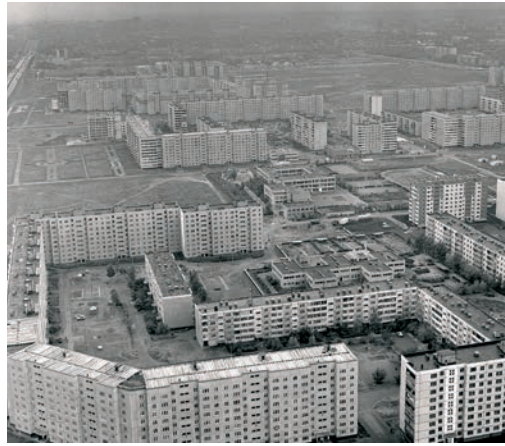
| Строится новый микрорайон Оренбурга
