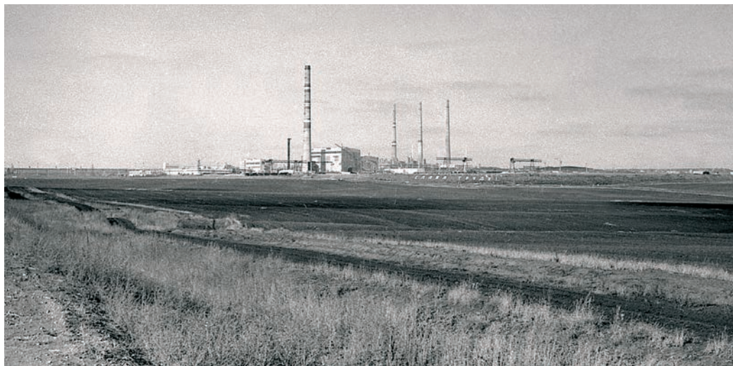
| Строительство газоперерабатывающего завода
