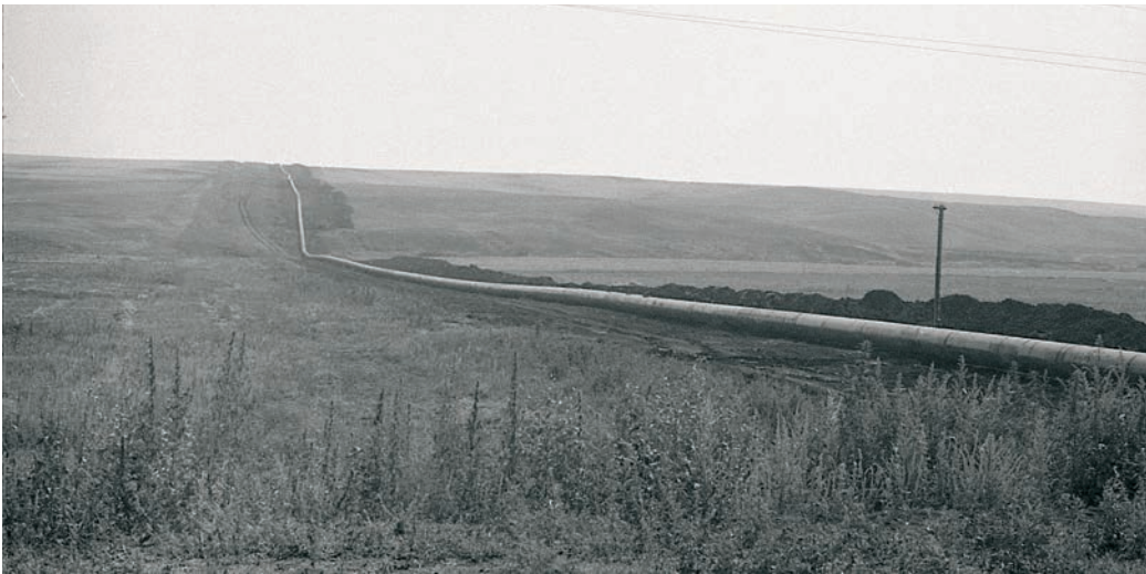
| Магистральный газопровод «Союз»
