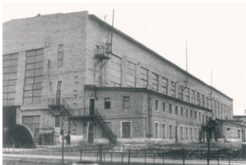
| Установка компрессии цеха водной отмывки CO 2
