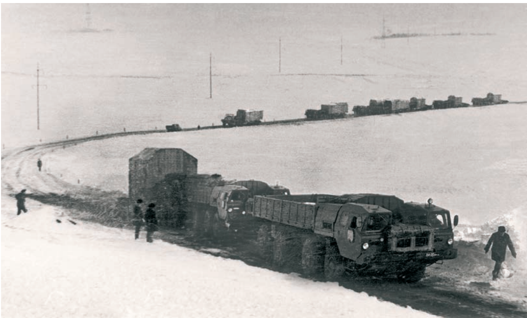
Доставка более 110 тонн технического оборудования: турбин и нагнетателей на Алексеевскую компрессорную станцию. 2–4 марта 1976 года
