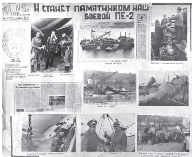
Стенд, который находился в музее школы г.Электенай (Литва).
