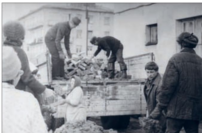
На субботнике – строительство пристройки к поликлинике № 1
