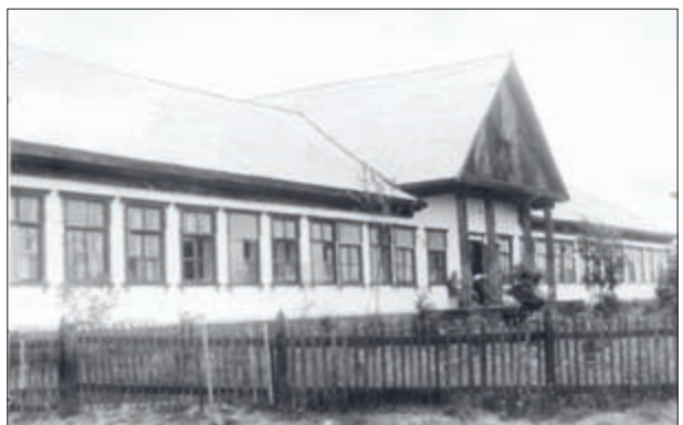
Тубкорпус больницы № 9. 1958 г.
