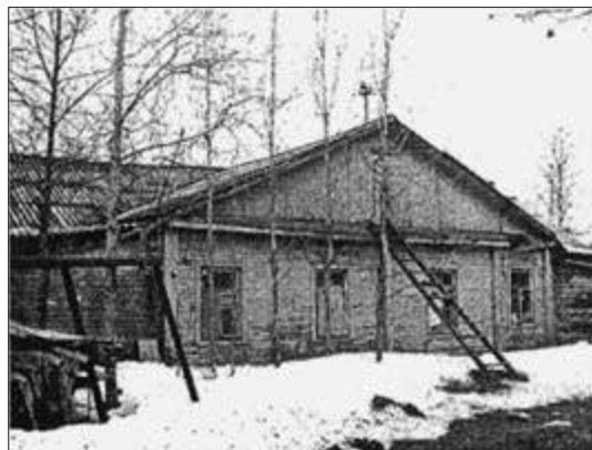
Сохранившийся корпус лазарета № 5, затем дома младенца, в 50-е – 60-е годы здесь находилось инфекционное отделение райбольницы. Дом на ул. Калинина, 2007 г.
