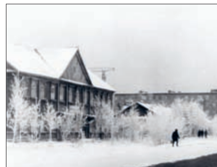
Детская поликлиника в двухэтажном деревянном здании
