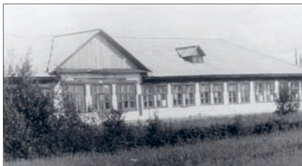
Хирургический корпус больницы № 9. 1960 г.
