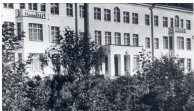
Главный лечебный корпус больницы, сдан в эксплуатацию в январе 1954 г.
