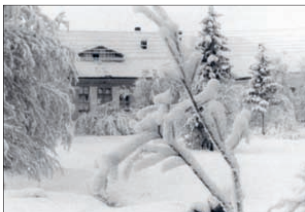
Инфекционный корпус больницы
