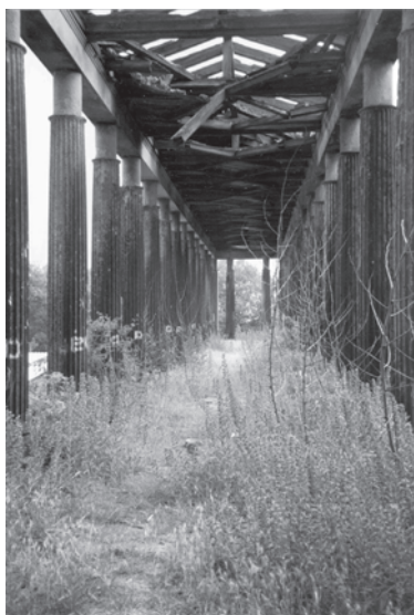
Илл. 4. Южная колоннада до реставрации. Фото 1997 г.
