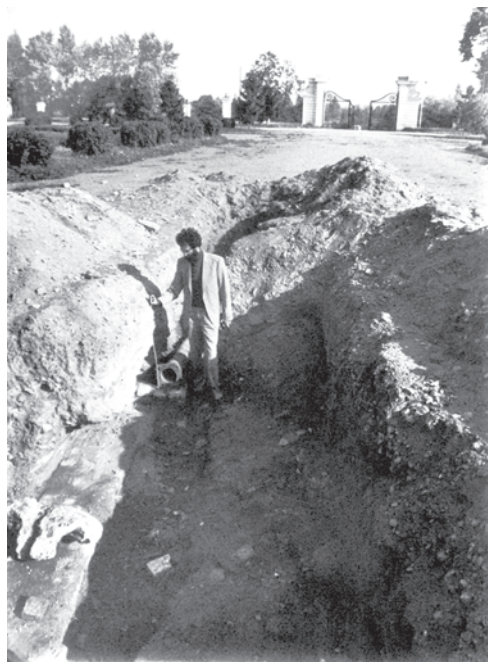
Илл. 4. Раскопки центрального фонтана. Спускной водопровод из чугунных труб. 1983
