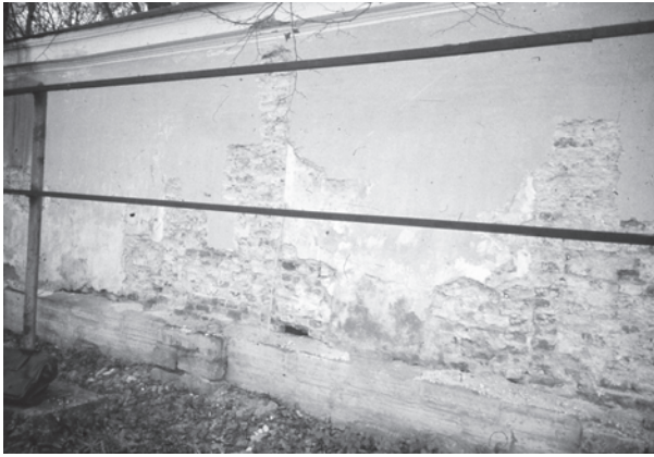
Илл. 10. Большой дворец. Узкая пилястра поверх широкой лопатки. Зондаж на северной фасадной стене открыл фрагмент архитектурного декора первого одноэтажного дворца, заложенного, возможно, в 1711 г. 1983
