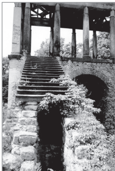
Илл. 5. Лестница к южной колоннаде перед террасой над Передним залом. До реставрации. Фото 1997 г.
