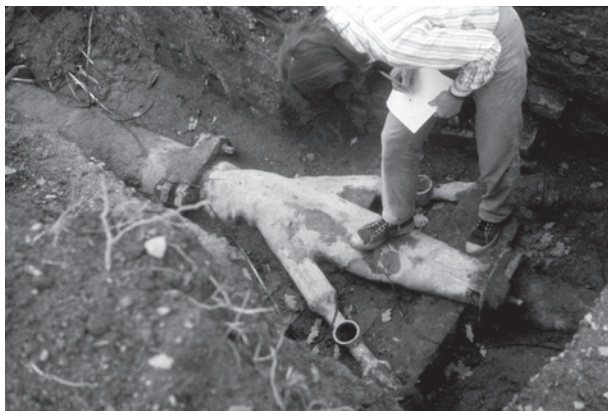
Илл. 6. Свинцовая муфта, с помощью которой магистральный водопровод был связан с тремя водопроводами к фонтанам Нижнего сада. 1983
