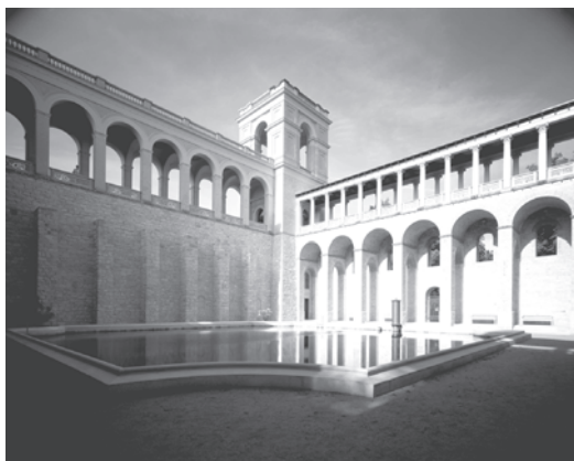
Илл. 10. Общий вид Бельведера после реставрации. Фото 2003 г.
