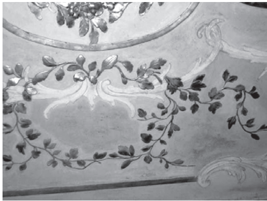
Илл. 12. Падуга потолка. Штукатурный покой. Современный вид
