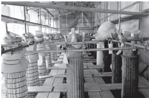
Илл. 8. Очистка обветшалых колонн от солевых отложений. Фото 2000 г.
