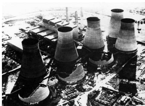
Разрушение градирен в Феррибридже (Великобритания, 1965)
