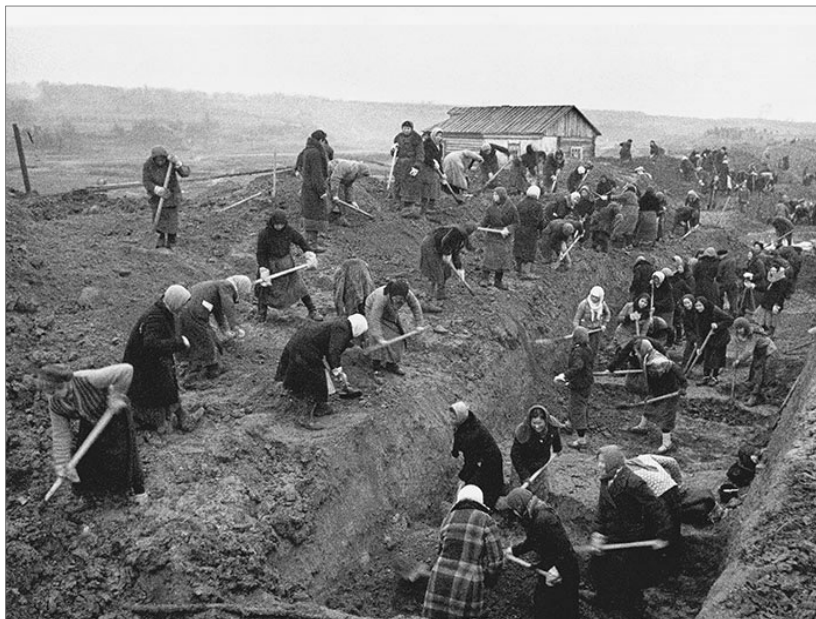
Строительство оборонительных сооружений под Москвой. Октябрь 1941
