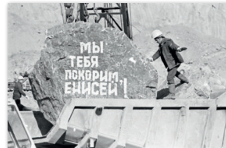
Перекрытие Енисея. Карлов створ. Саяно-Шушенская ГЭС. 11 октября 1975 года. Фото Виктора Ахломова
