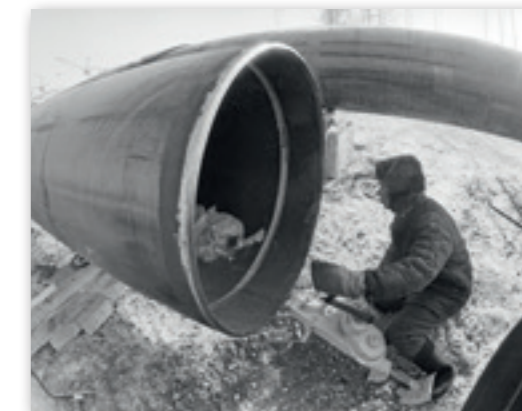
Монтажные работы на нефтепроводе. Сибирь. 1970-е годы. Фото Виктора Ахломова
