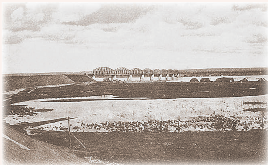
Мост через реку Каму
