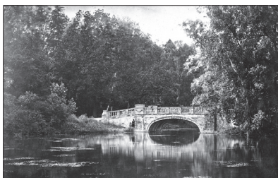
Малый каменный мост Фото до 1917. ГМЗ «Гатчина».
