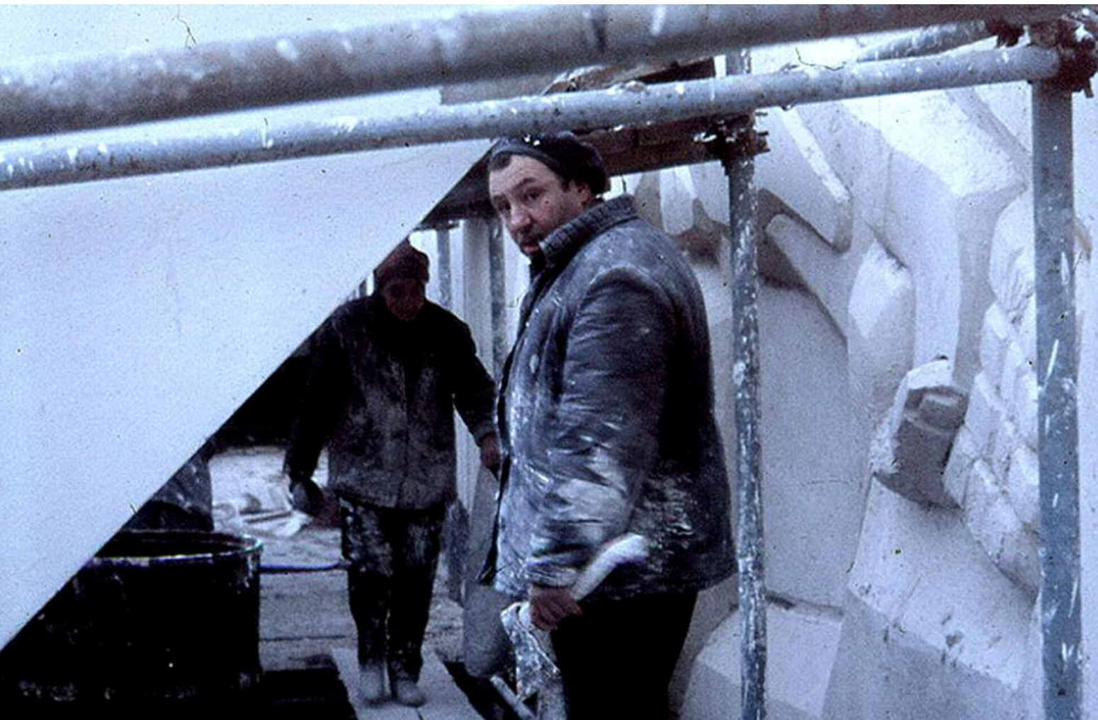
Эрнст Неизвестный. Работа над горельефом в первом корпусе МИЭТа. Зеленогорск, 1970
