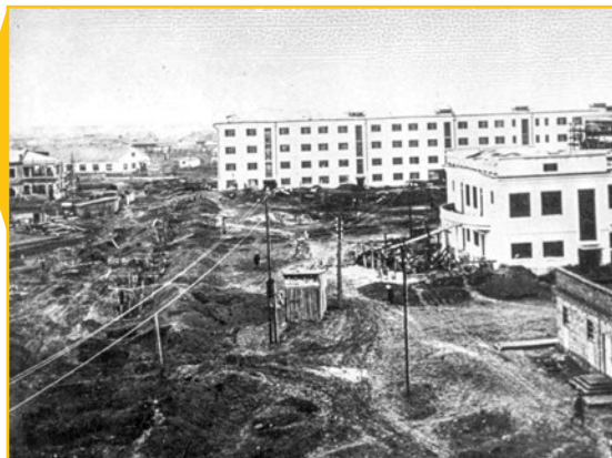
Строительство жилкомбината ТЭЦ на притомском участке. 1931-32 гг.
