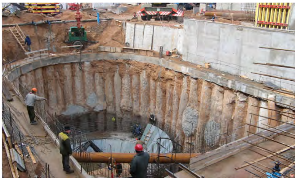
Реконструкция Белорусского металлургического завода. Крепление котлована буронабивными сваями диаметром 100 см. Внедрение НИР кафедры ГиЭС
