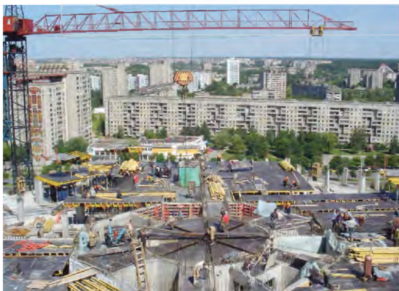
Так выглядела на начальной стадии строительная площадка возведения Национальной библиотеки Республики Беларусь. Генеральный подрядчик ОАО «Стройтрест №7», ГПЮ «Минскстрой»
