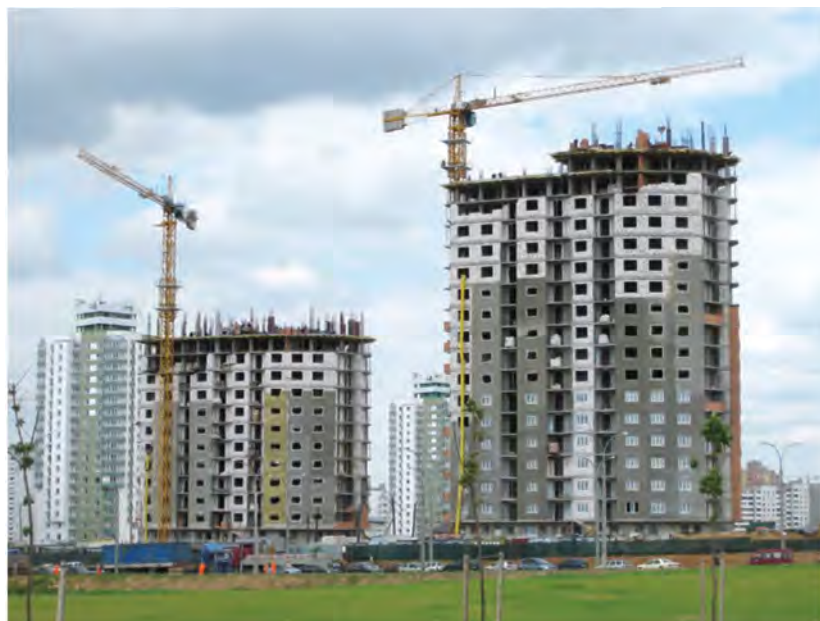
Строительство 25-этажных энергоэффективных домов. Объекты ОАО «10 УНР». Предприятие многие годы возглавляет В.А. Устинчик, выпускник 1977 г.
