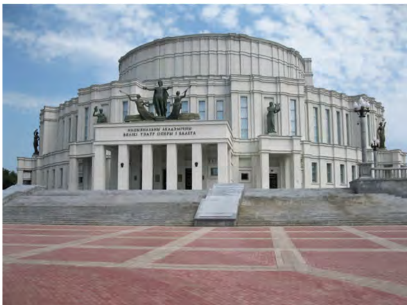
Так выглядит здание театра после окончания реконструкции
