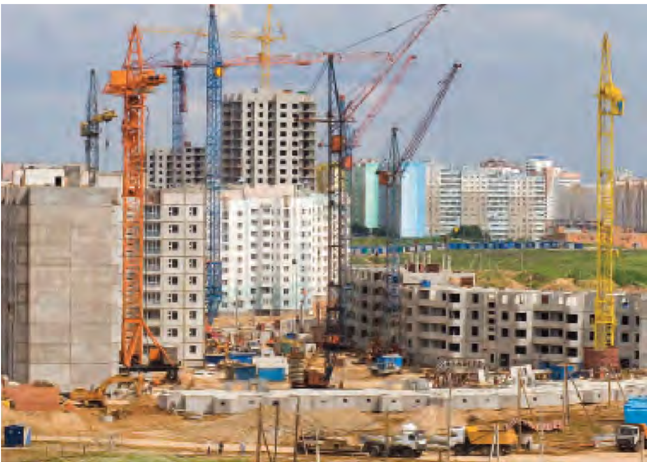
Микрорайон «Каменная горка» интенсивно застраивается. Панорама 2010 г. Строительство ведет МАПИД
