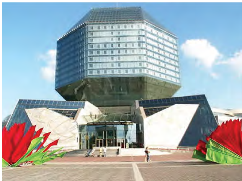
Так выглядит здание Национальной библиотеки Республики Беларусь по завершению строительства
