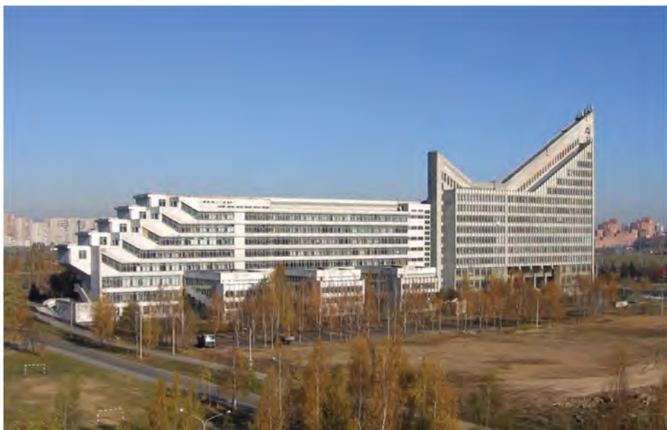
Учебный корпус БПИ №15 по завершению строительства. 1982 г.
