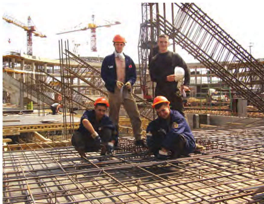
Бойцы ССО работали на строительстве комплекса «Минск-Арена»
