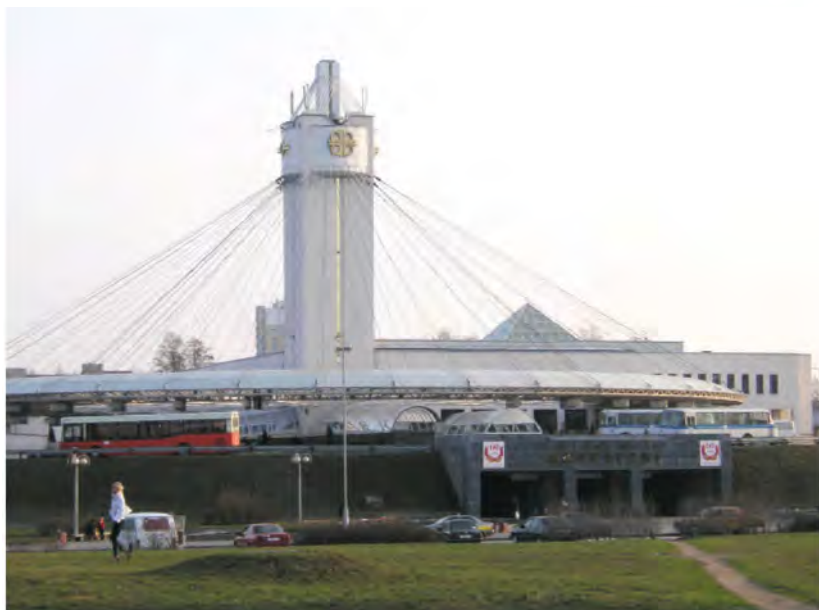
Здание автовокзала «Московский», построенное ОАО «Стройтрест №7». С 1992 г. предприятие возглавляет выпускник строительного факультета Л.А. Леухненко
