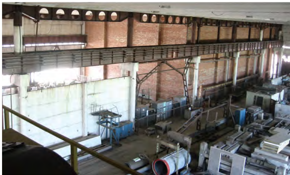
Учебно-лабораторный корпус №16. Цех испытания конструкций
