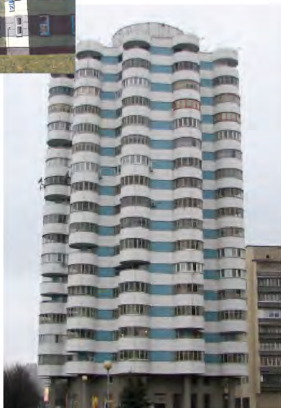
Первый дом повышенной этажности по улице В. Хоружей в г. Минске. Выполнением строительно-монтажных работ руководил Е.И. Вовна, выпускник строительного факультета 1986 г. Ныне он возглавляет ГПО «Минкстрой»
