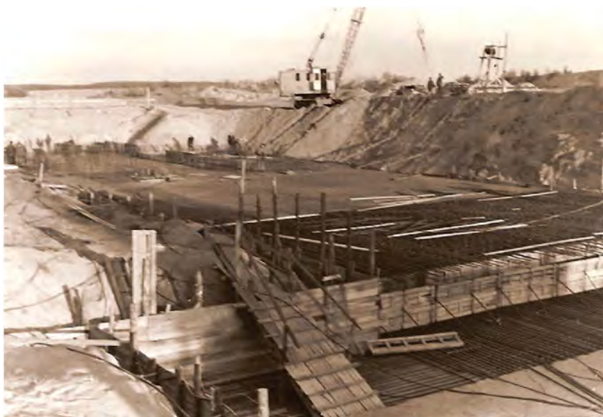
Строительство 15 корпуса набирает темпы
