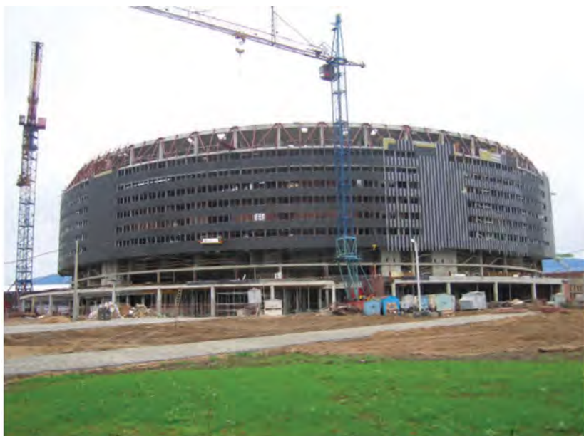
Приближается завершение строительных работ на комплексе «Минск-Арена»
