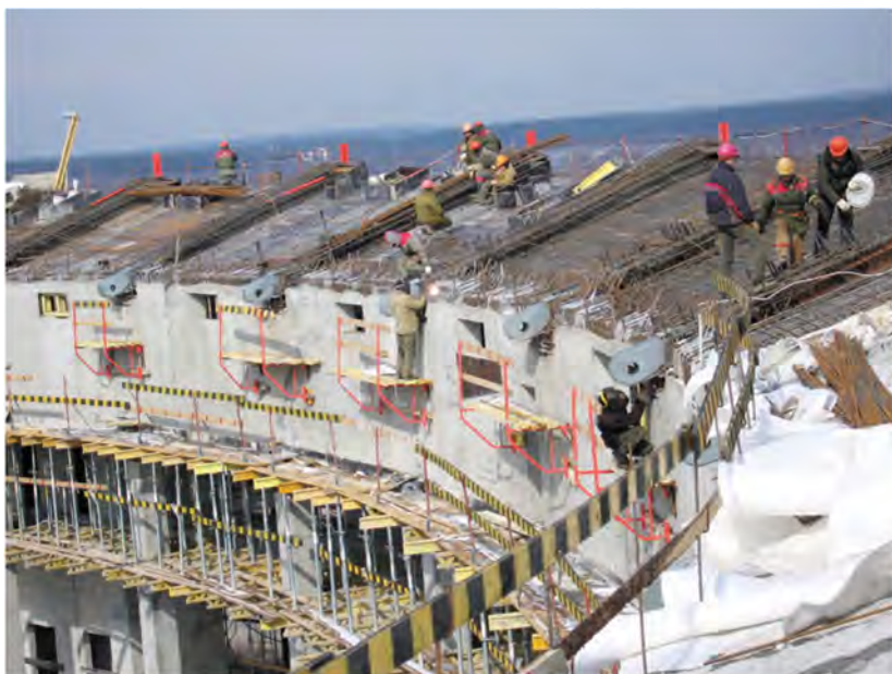
Работы по созданию железобетонного опорного пояса огромного купола «Минск-Арена»
