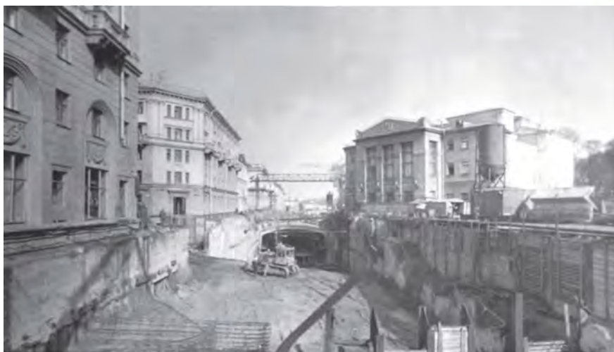
Котлован на стадии строительства станции метро «Купаловская». Здесь в значительных объемах использовались методы крепления котлована бура-инъекционными системами, разработанными кафедрой основания и фундаменты, руководитель М.И. Никитенко
