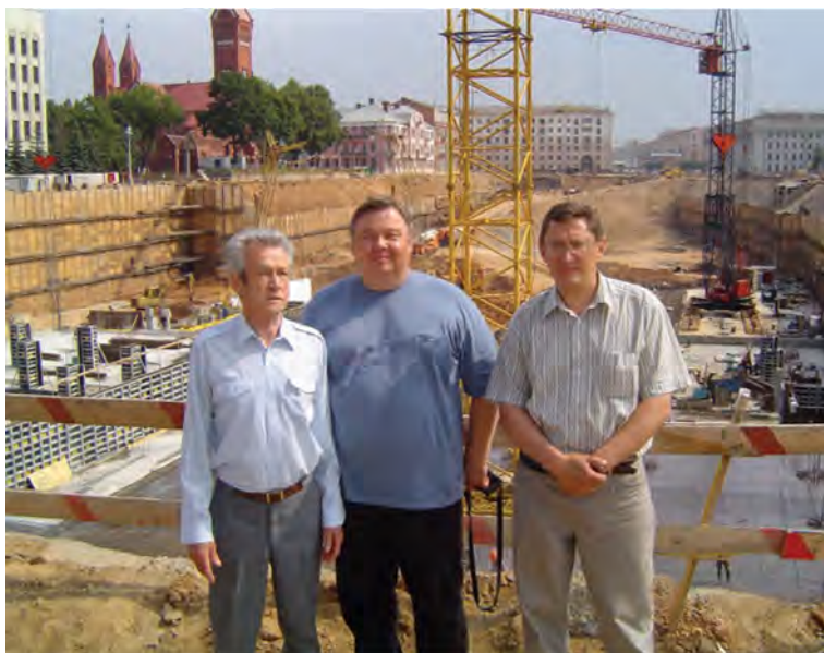
Руководители производственной практики студентов специальности ПГС профессора Э.В. Овчинников, С.Н. Леонович и зам. главного инженера СУ-25 «Минскпромстроя» А.В. Гарбацевич в период реконструкции пл. Независимости 2005 год.
