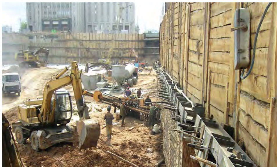
Крепление котлована системой буроинъекционных анкеров. Внедрение НИР кафедры ГиЭС при реконструкции пл. Независимости, 2004 г.
