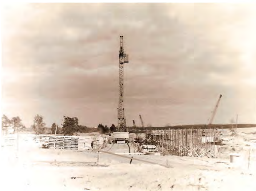
Так выглядел котлован строительства 15 корпуса в 1978 г.
