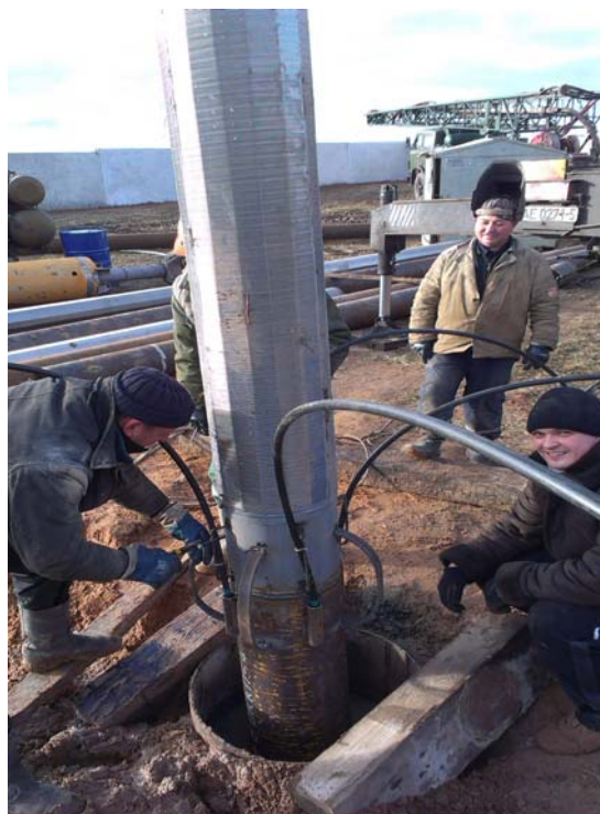
Скважина с затрубной системой промывки: а – конструкция; б – общий вид
