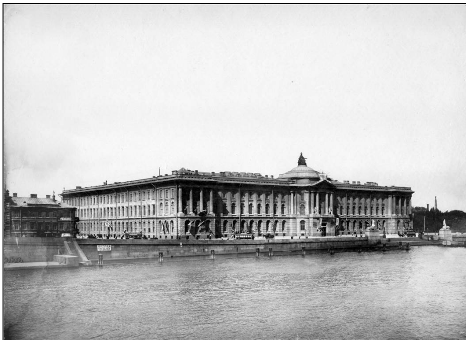
Ил. 1. Здание Императорской Академии художеств со статуей Минервы на куполе. До 1900. © НИМ РАХ
