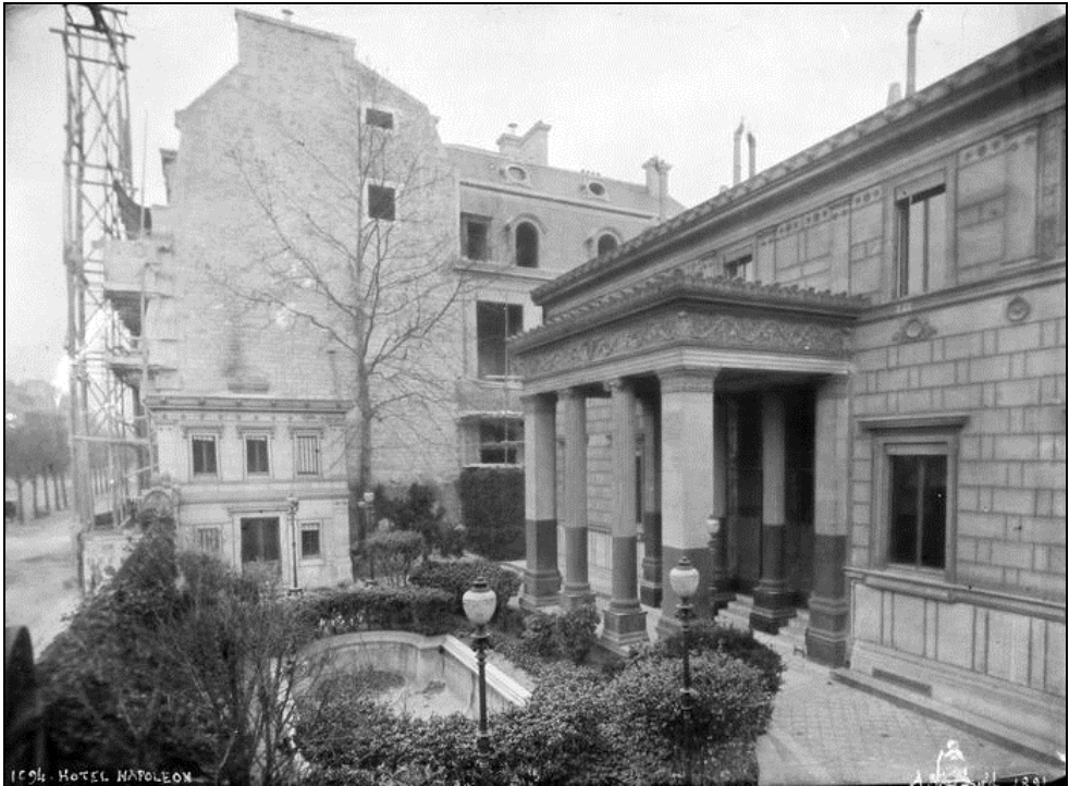
Ил. 4. Альфред-Николя Норман. Париж. Помпейский особняк Наполеона Портик перед входом. 1891. Негатив. Желатино-бромидная печать. 18,0 × 24,0 © Médiathèque de l'architecture et du patrimoine (France)
