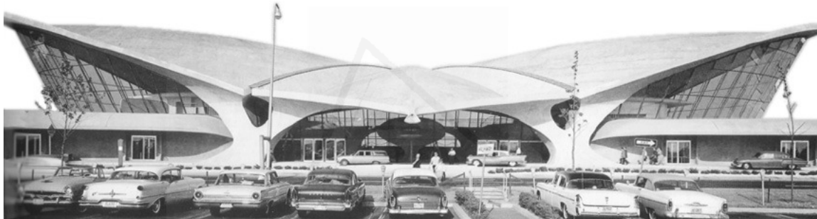
Imagen 112: Fachada principal de la Terminal de pasajeros de la TWA del Aeropuerto Kennedy en Nueva York. Ilustración extraída de "Eero Saarinen. TWA Terminal. Il calcolo e l'invenzione" (Papademetriou, 2001, p.27).
