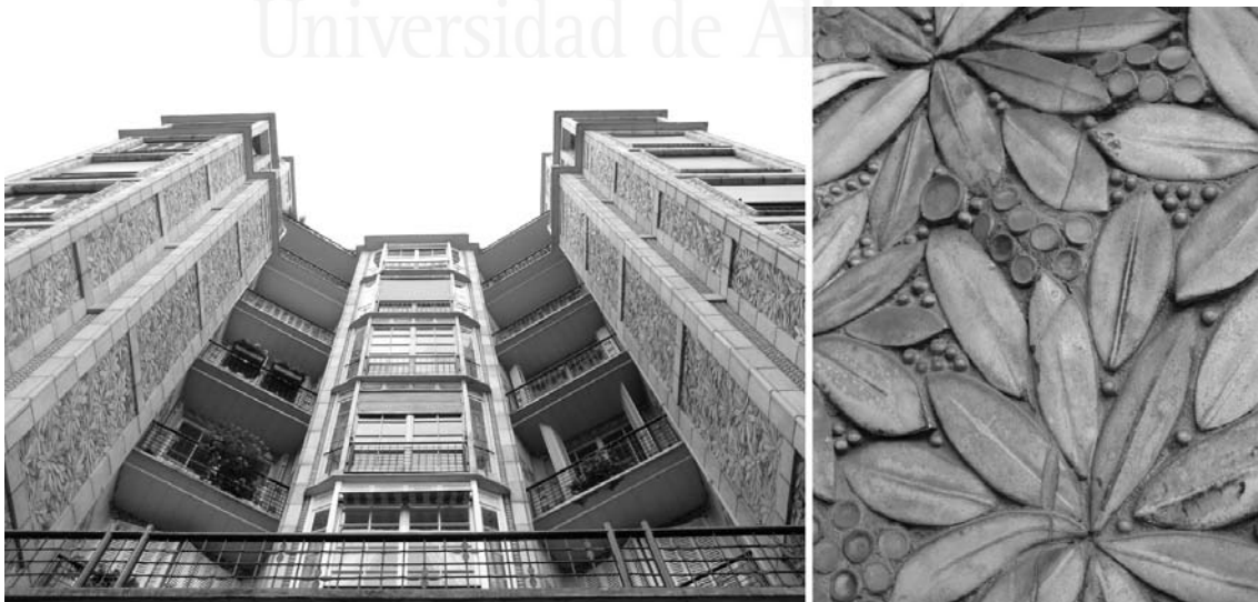
Imagen 108: Edificio en la Rue Franklin N°25, París, de Auguste Perret (1903). Fotografías del autor.
