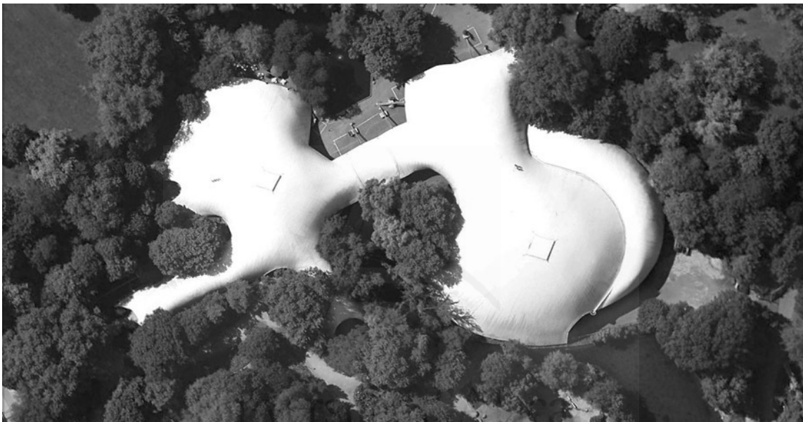
Imagen 148: Vista aérea de la cubierta del Multihalle de Mannheim desde 200 metros de altura. Imagen obtenida en enero de 2012 con el programa Google Earth.
