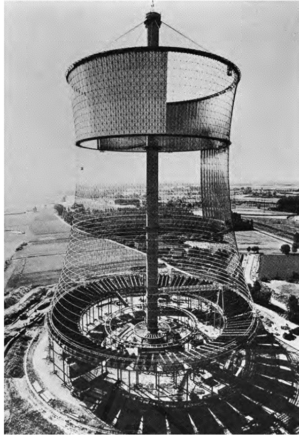
Imagen 131: Torre de enfriamiento en Schemehausen, diseñada por Leonhardt y Andra, 1975. Ilustración extraída de " A brief history of cable and membrane roofs " (Forster, 1980, p.10).
