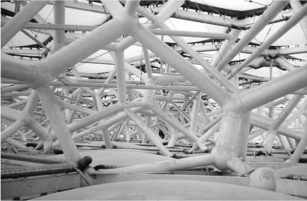
Imagen 94: Detalle de la malla estructural durante el proceso de obra. Ilustración extraída de " Calado de espuma. Centro Nacional de Natación " (Arquitectura Viva, 2008, p.108).
