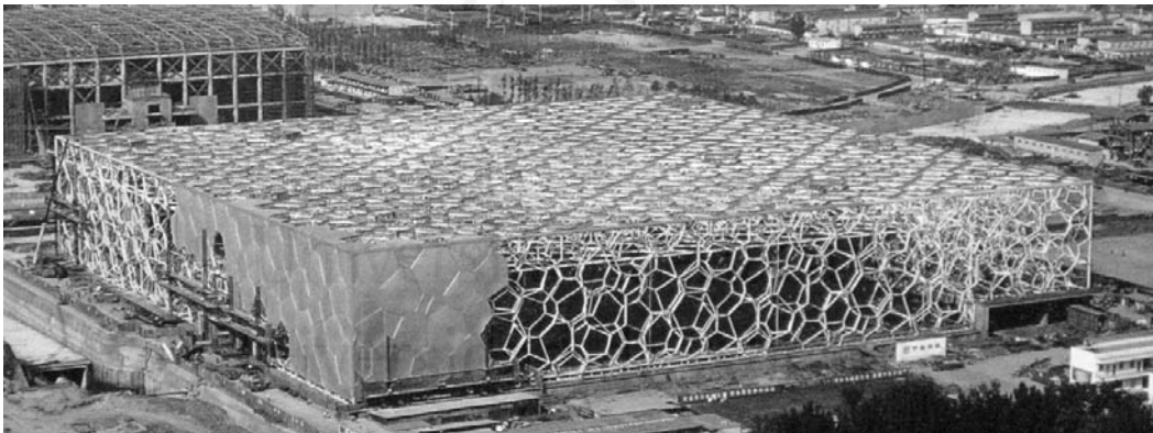
Imagen 94: Detalle de la malla estructural durante el proceso de obra. Ilustración extraída de " Calado de espuma. Centro Nacional de Natación " (Arquitectura Viva, 2008, p.108).
