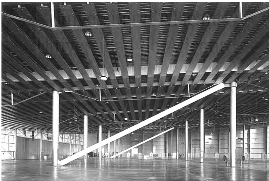
Imagen 271: Vista interior del edificio Expo. Ilustración extraída de " Lille Grand Palais: Zenith/Congres/Expo; Architects: Rem Koolhaas " (Mc Gowan et al., 1995, p.23).
