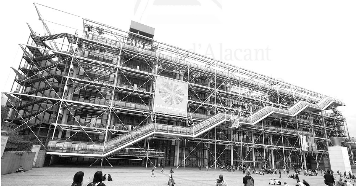
Imagen 78: La plaza y la fachada principal del Centro Pompidou. Ilustración extraída de Internet < http://www.vigoenfotos.com/paris/paris_pompidou_centre_museo_1.html >.
