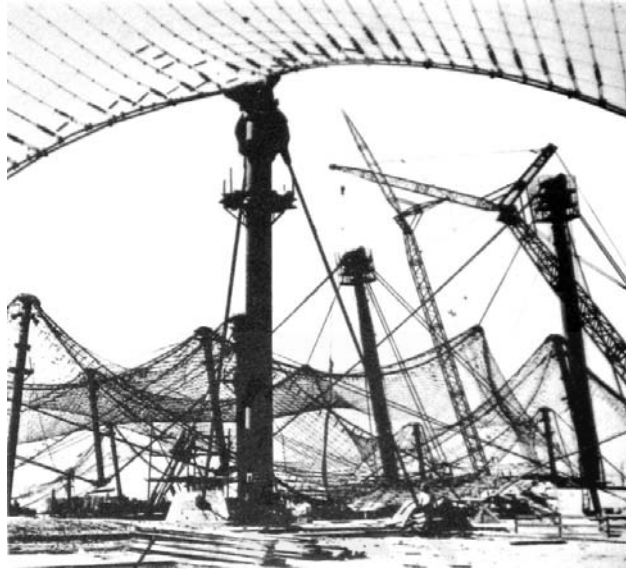
Imagen 142: Edificios para las Olimpiadas de Munich de 1972, vista de la malla de la cubierta del estadio inmediatamente luego de tendida. Ilustración extraída de " Frei Otto and the Munich Olympic Games (from the measuring experimental models to the computer determination of the pattern) " (Eeckhout, 1972, p.50).
