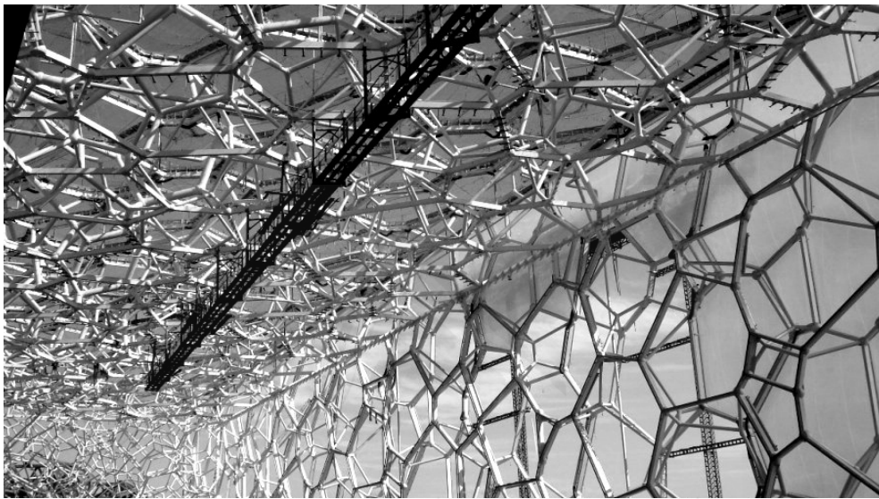
Imagen 171: Montaje de las almohadillas de ETFE en la estructura de acero. Ilustración extraída de Internet < http://www.oasys-software.com/casestudies?id=18/ >.
