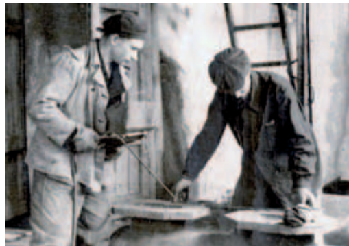
1955 год. Ремонтно-механическая мастерская Похвистневского ЛПУМГ. Сварщик Василий Лобачев
