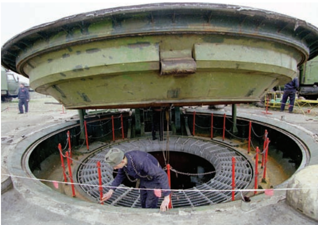
Захисний пристрій шахтно-пускової установки ракети РС-22.
