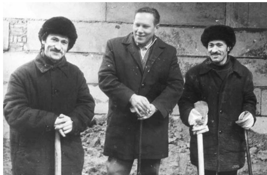
Ладыгин Е.А. на строительстве лаборатории радиационных технологий
