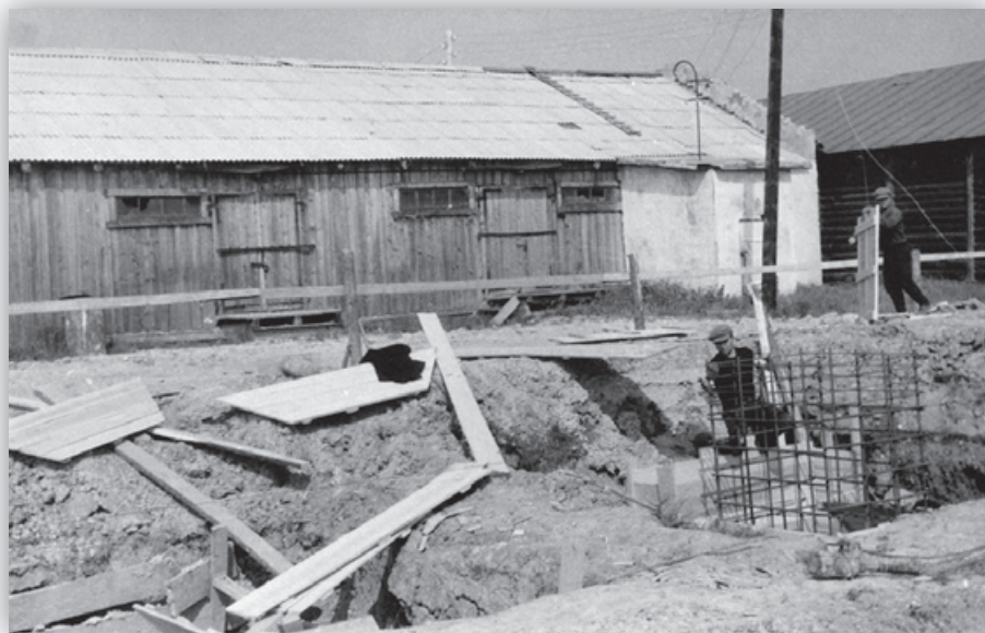
Строится бытовой корпус, 1965 г.
