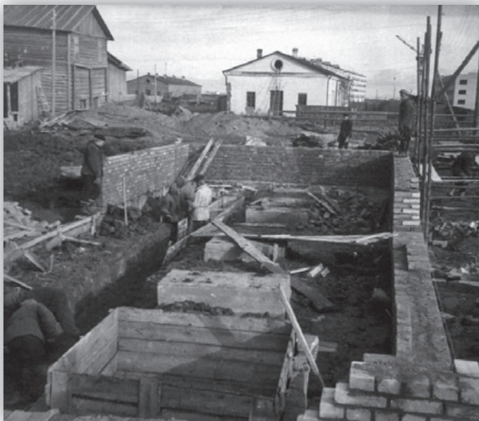
Строятся первые здания, 1965 г.
