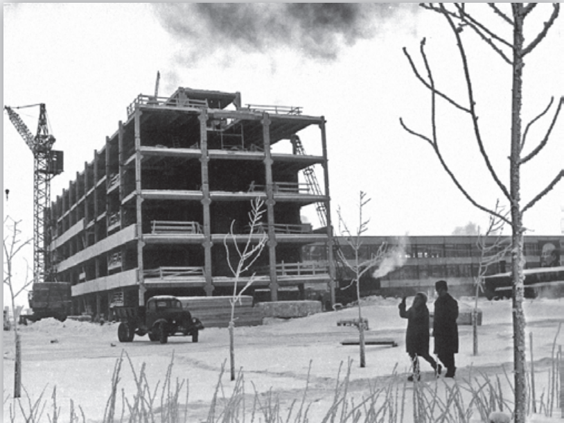
Возводится здание (ныне СКТБ)
