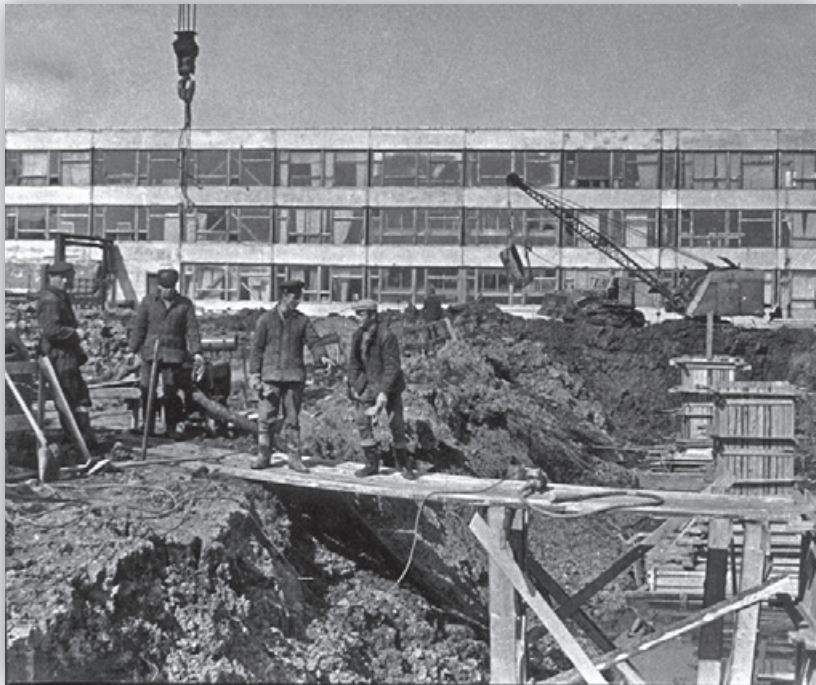
Строительство производственных корпусов завода, 1968 г.
