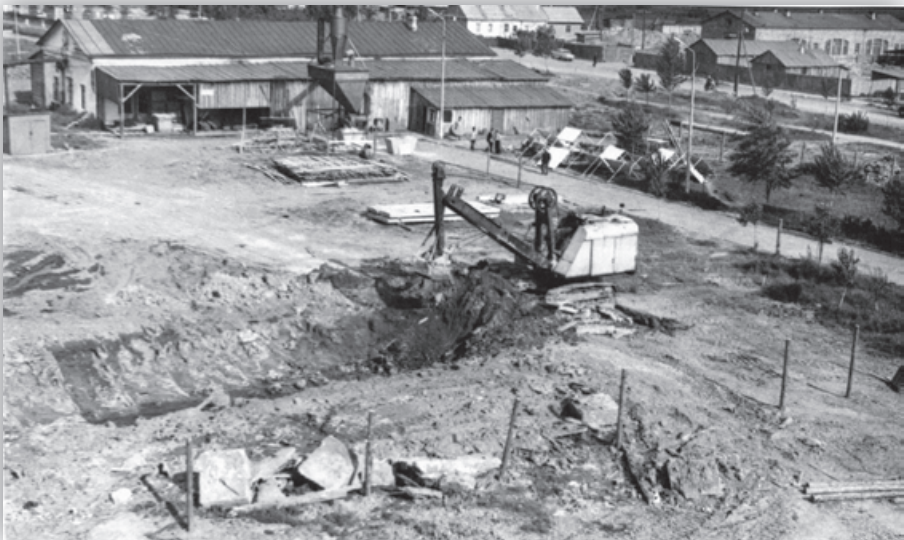
Начало строительства столовой, 1974 г.
