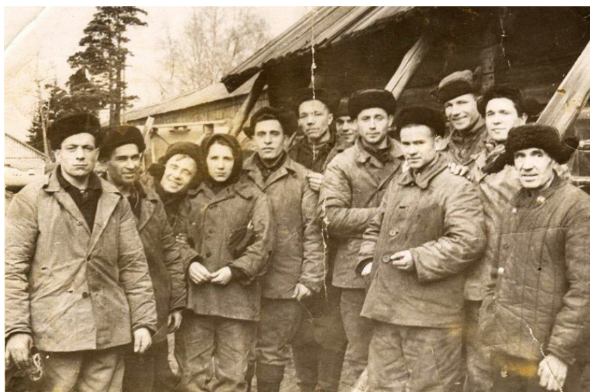
Электросварщики ССЦ. 1962 г.
