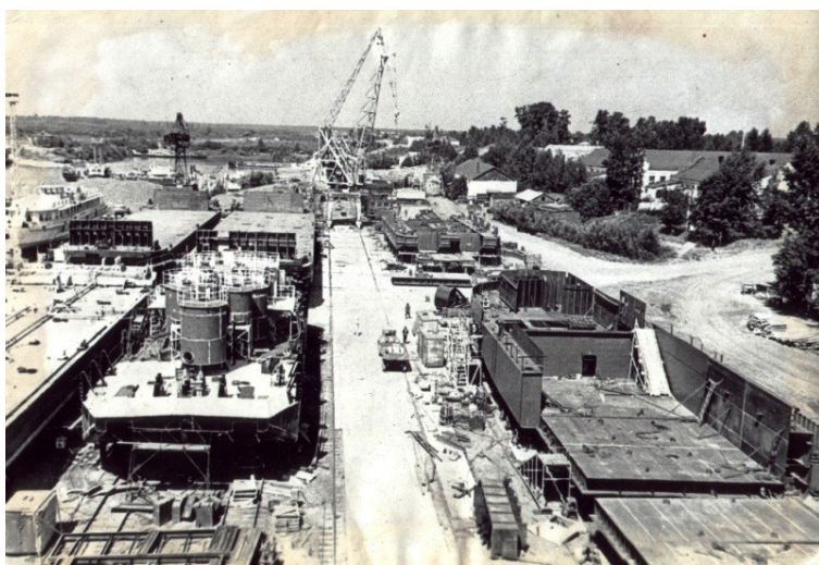
Одновременно строятся: теплоход Р25Б, бункербаза Р16К, плавкран 27 тонн
