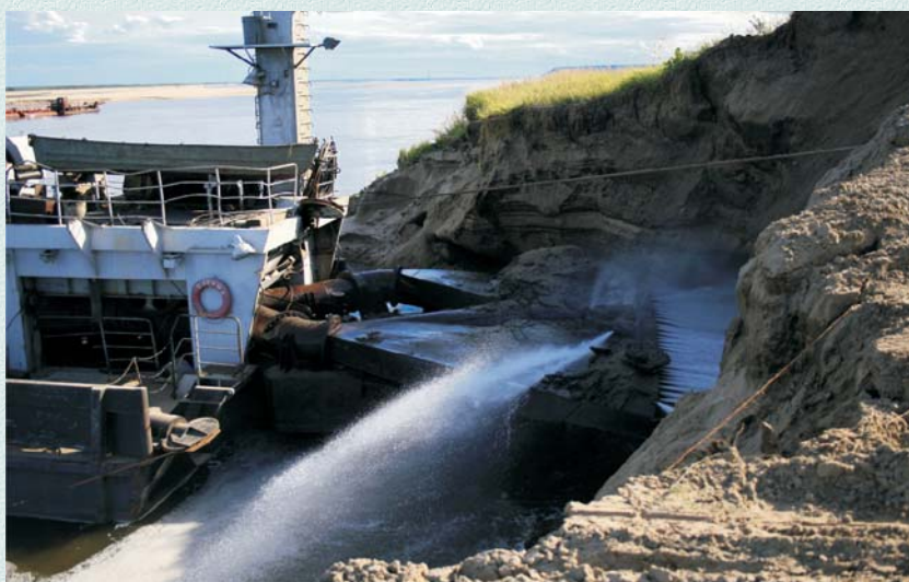
Размыв берегового выступа земснарядом (р. Лена, пос. Табага, 2009 г).
