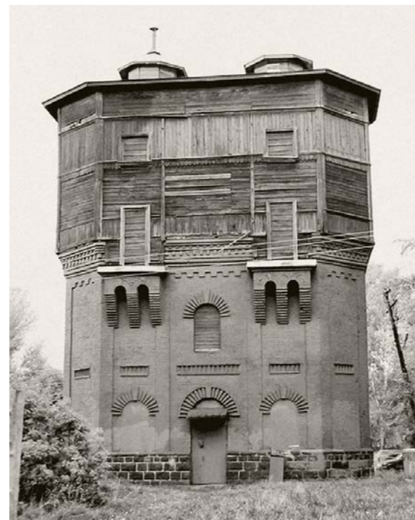
Водонапорная башня для заправки паровозов. Тихвин. Начало XX в. 2016 г.
