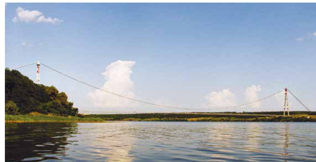
Вантовый переход аммиакопровода над Днепром.
