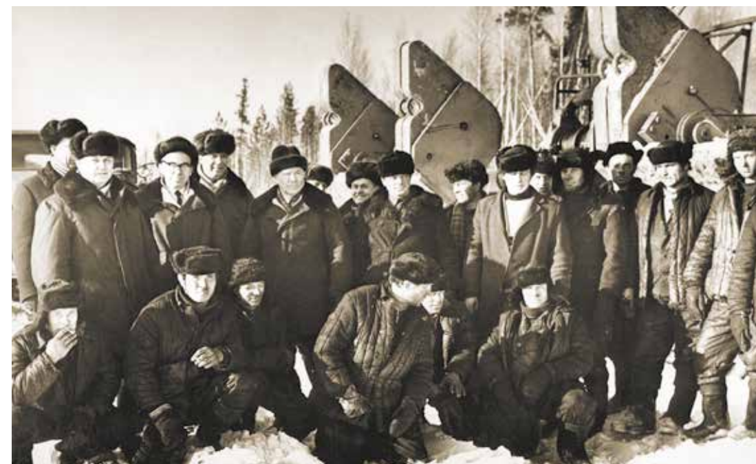
На строительстве нефтепровода Александровское – Анжеро-Судженск с Первым секретарём Томского обкома КПСС Е.К. Лигачёвым и Министром газовой промышленности СССР А.К. Кортуновым
