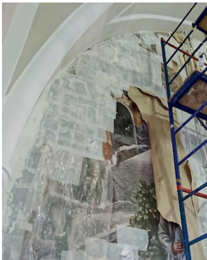
Ил. 4. Фреска «Международная обстановка 1920-1930 годов» в процессе укрепления штукатурки методом инъектирования
